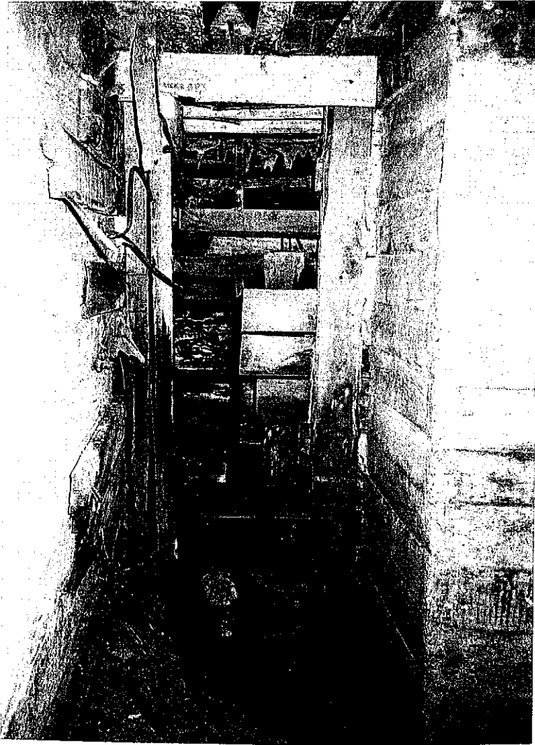
Purkamatonta laudoitusta (kuva 10) sekä mikrobikasvustoa maan päällä. Päätyseinällä tuuletusaukko. Kuva 4.
