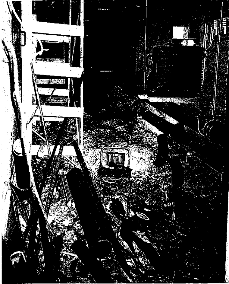
Alustatilassa on puisia telineitä sekä rakennusjätettä. Tuuletusventtiilistä on suora yhteys lämmönjakuhuoneeseen. Kuvat 8 ja 9.
