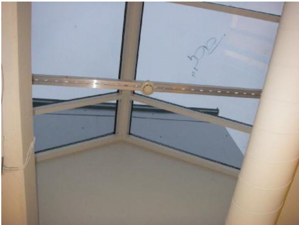
Kattoikkunoissa ei havaittu vaurioita eikä vuotoja.
