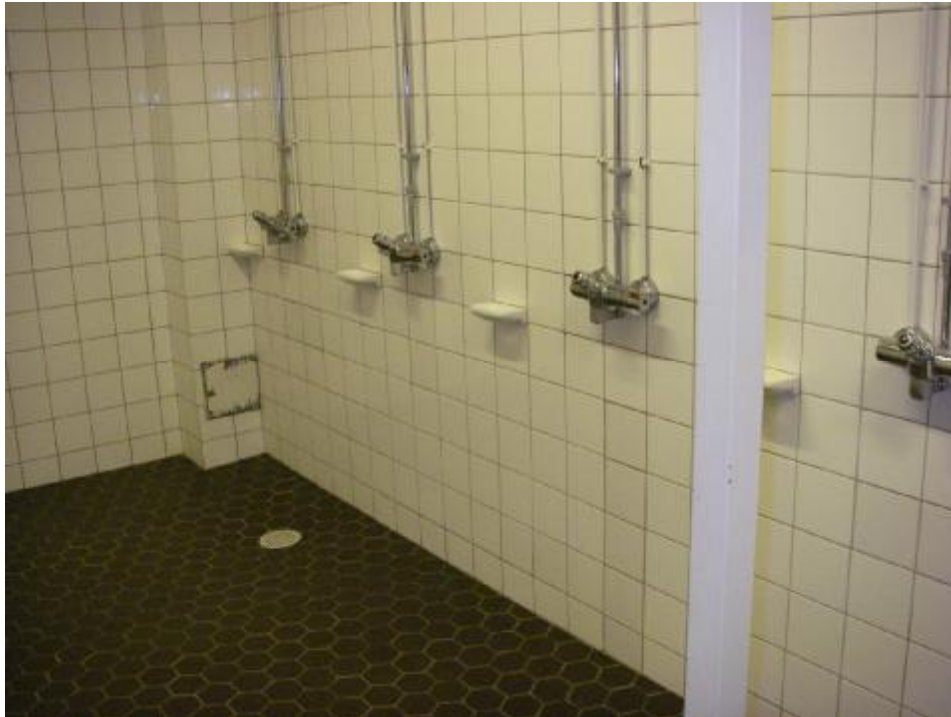
Suihkutilojen rakenteissa ei havaittu haitallista kosteutta, mutta ne alkavat olla teknisen käyttökänsä lopussa.
