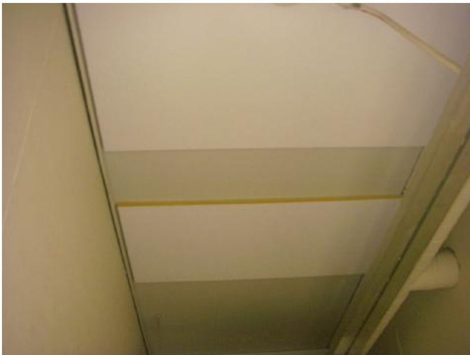
Sisäkattojen pinnoittamattomista akustiikkalevyjen reunoista voi irrota kuituja, jotka voivat aiheuttaa herkimmille ihmisille terveysoireita. Ko. levyt on syytä vaihtaa muiden sisäremonttien yhteydessä.
