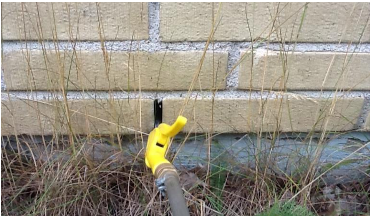
Merkkiainekaasua ruiskutettiin muurauksen tuuletusraosta.
