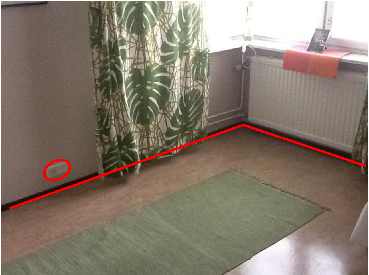
— Vuotavat kohdat Rakennus 1 pääoven vieressä
