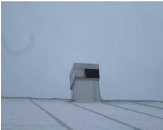
Kiinteistön katolla on 3 huippuimuria.
