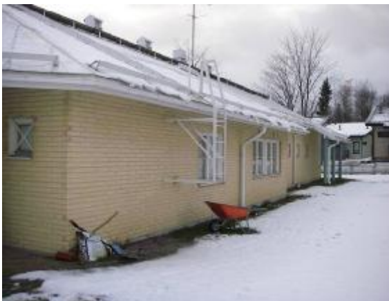
Yleiskuva rakennuksen ulkoseinäpinnasta.
