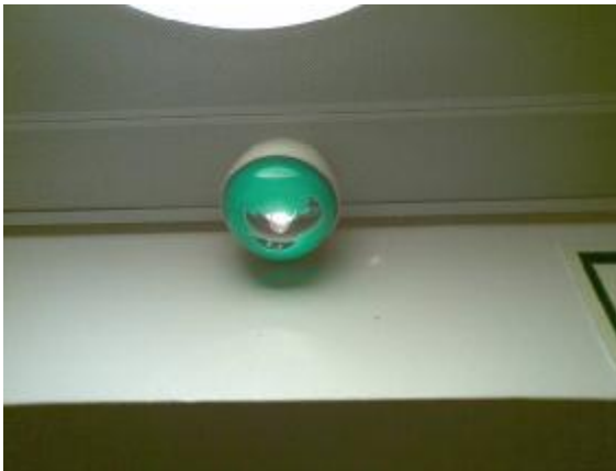
Poistumistievalaisimen kupu on rikki.
