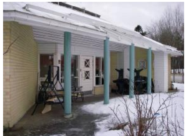
Puupinnat ovat suhteellisen hyvässä kunnossa.
