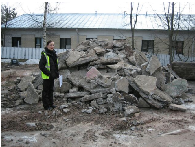
Kuva 1: Pilaantunutta pohjalaattaa.
