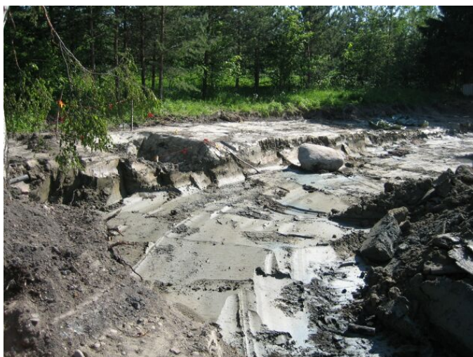
Kuva 3: Kaivupohja teollisuusrakennuksen pohjoisreunassa. Vasemmalla kaivantovesikuoppa.
