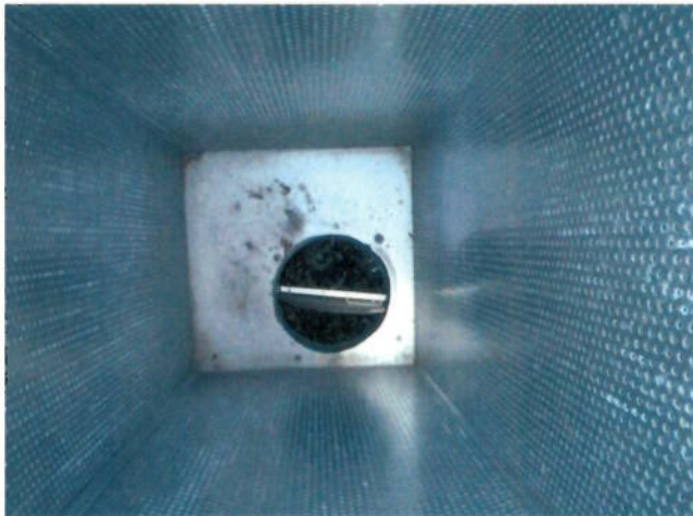
kuva 3 Pelti on auki ja moottori on kiristetty paikoilleen.
