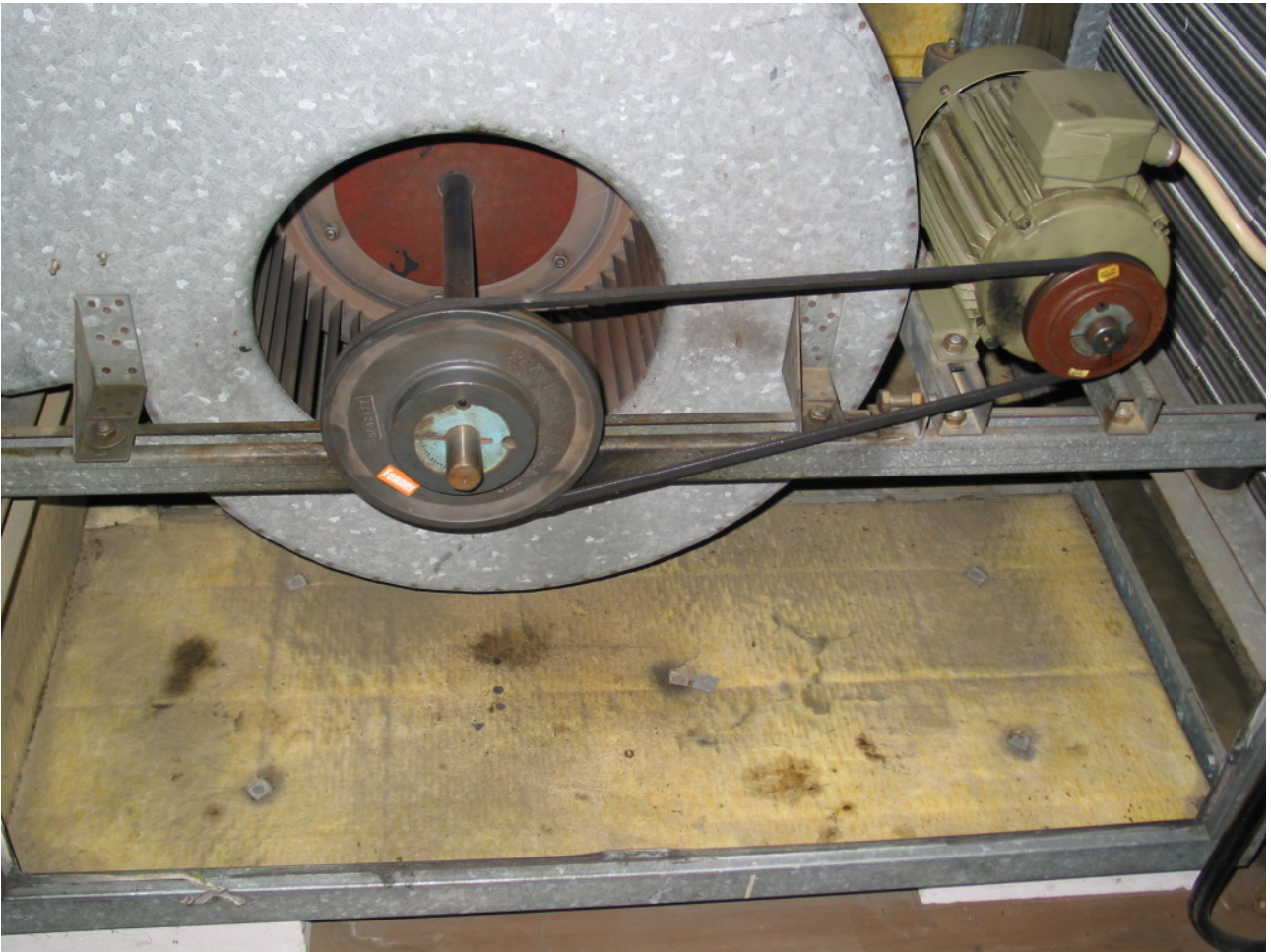
Kuva 3. IV-koneen sisäpinnat ovat villaa.
