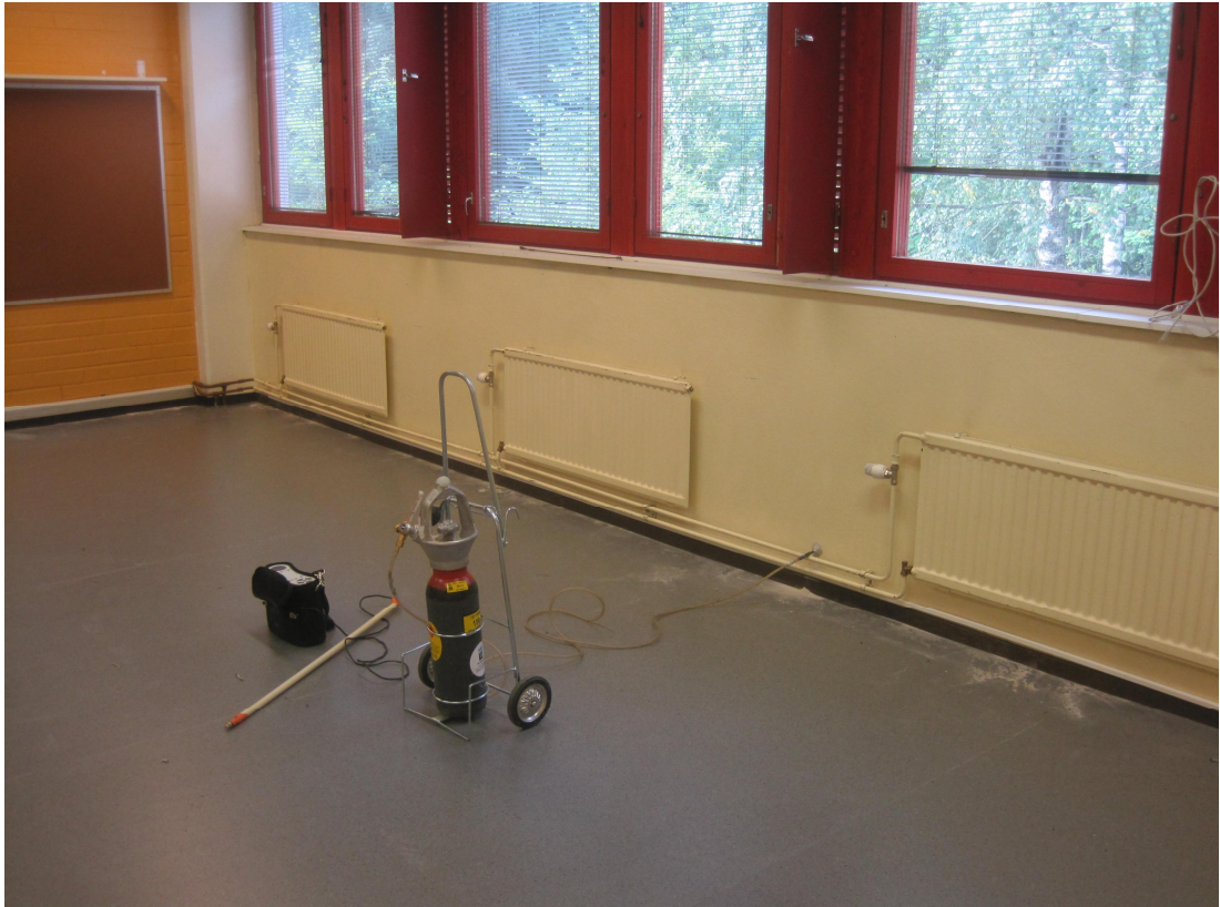
Kuva 3. Luokkahuoneen 206 ulkoseinä, johon suoritettiin merkkiainekoe.
