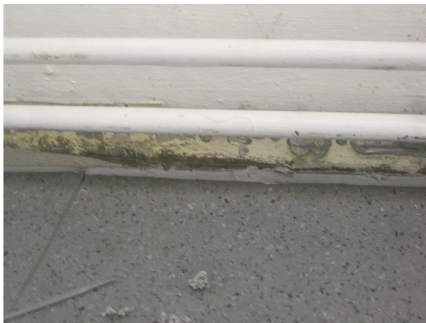
Kuva 5. Lattia-seinäliitosta ei ole puhdistettu kunnolla ennen tiivistystyön aloittamista.
