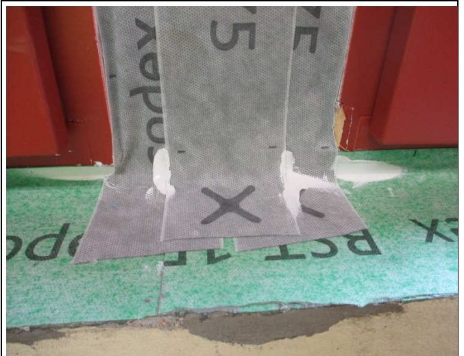
Elastisella kittauksella tiivistettyjä tiivistysnauhan liitoskohtia. Ilmavuotokohtia ei tähän liittyen havaittu.
