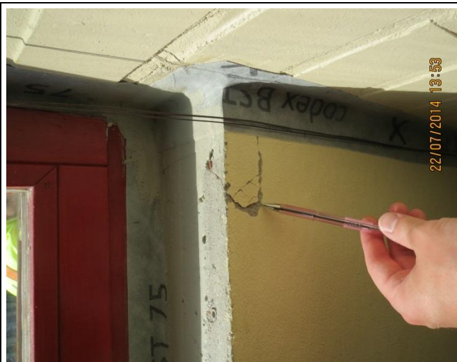
Kuva 4: vuotokohta, ikkunapenkin halkeama
