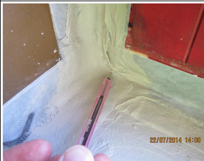
Kuva 8: vuotokohta, ikkunapenkin ja pilarin nurkka
