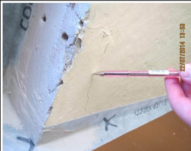
Kuva 5: vuotokohta, ikkunapenkin halkeama
