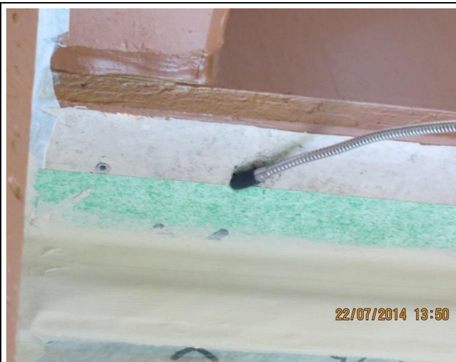
Kuva 3: vuotokohta, saumanauhan ja betonipalkin liitos
