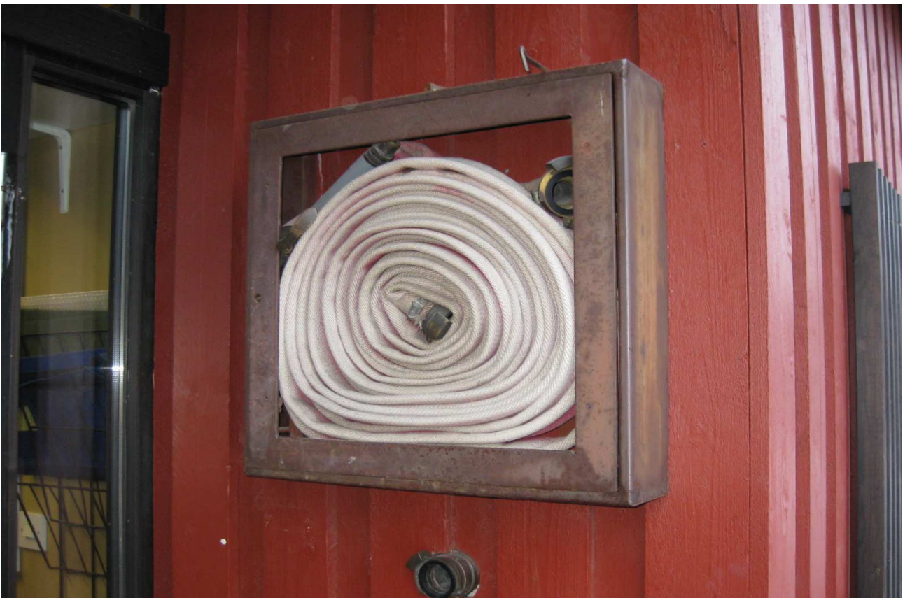
LVI-kuva 17. Palopostien toimivuus tulisi selvittää ja samalla tulee palopostin lasi uusiksi.
