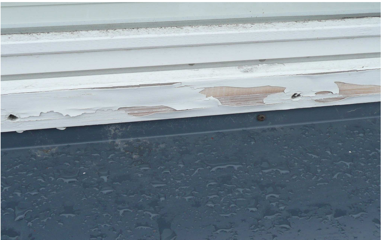
RAK-kuva 8. Yleiskuva päiväkodin ikkunoiden ulkopuitteista.
