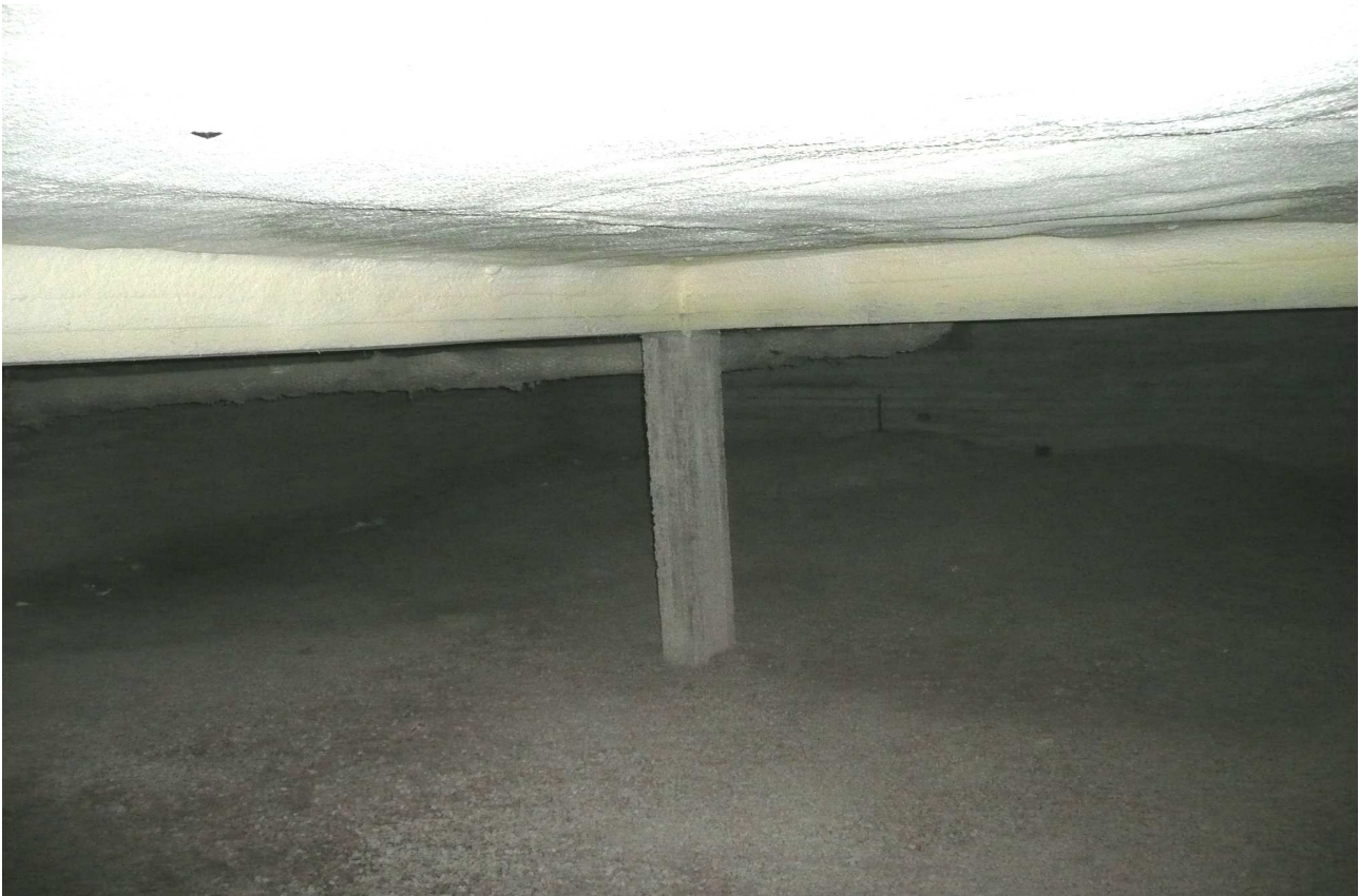
RAK-kuva 7. Yleiskuva lisärakennuksen alapohjasta.
