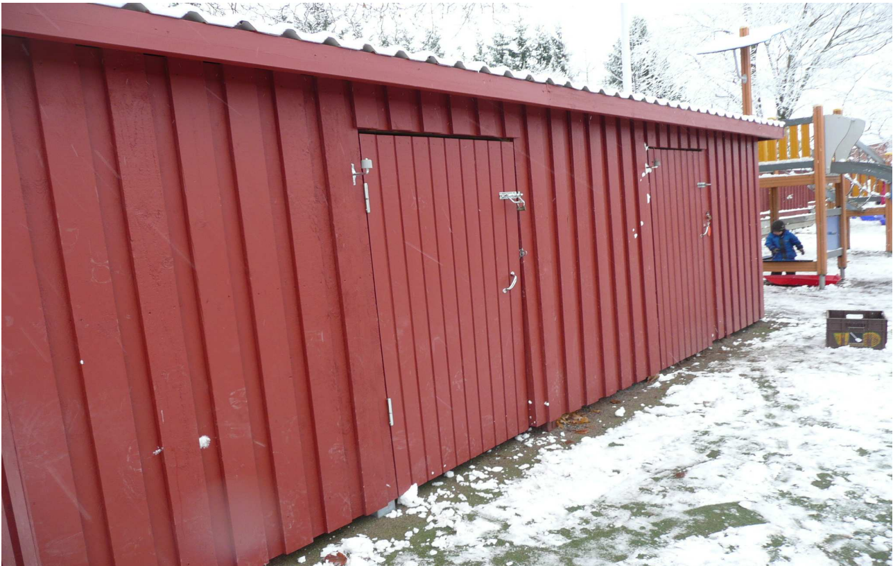
RAK-kuva 3. Varasto on hyvässä kunnossa.
