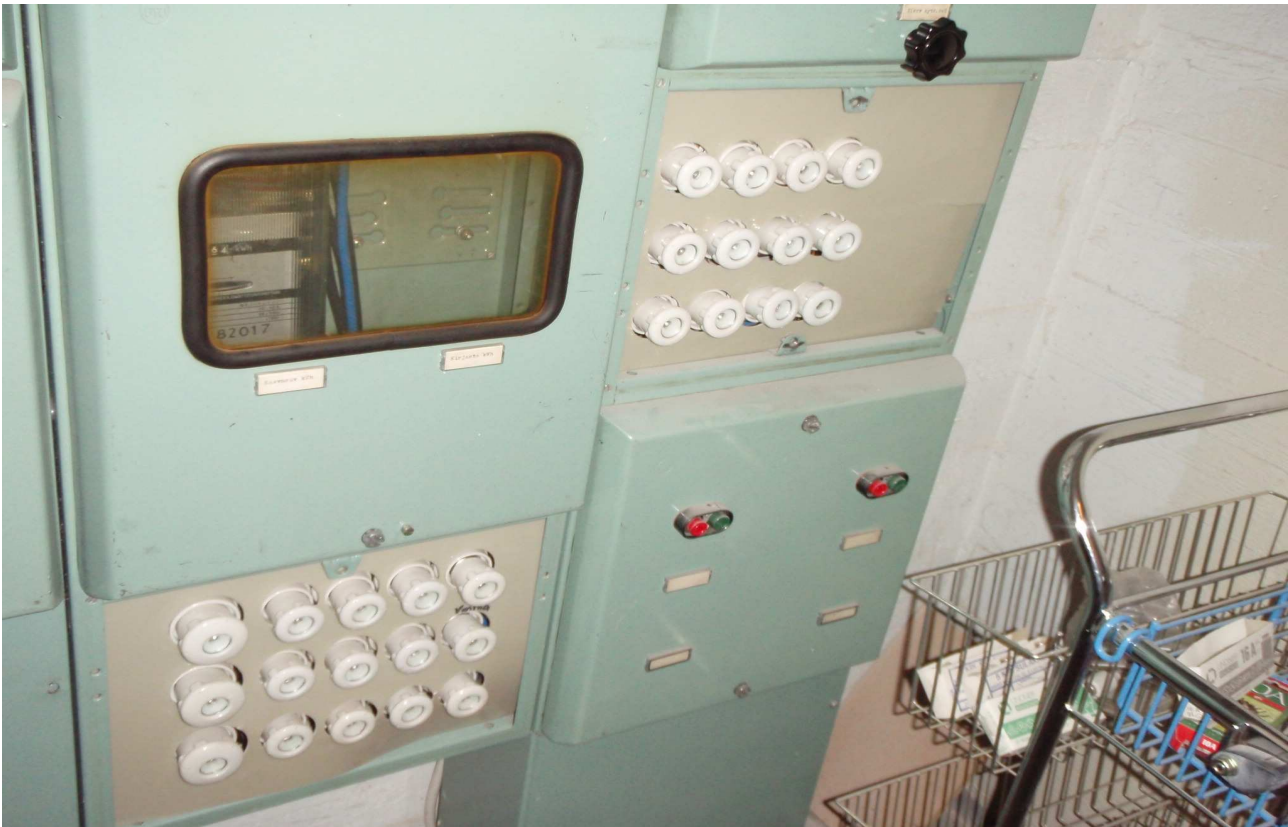
S-kuva 3. Sähköpääkeskus.
