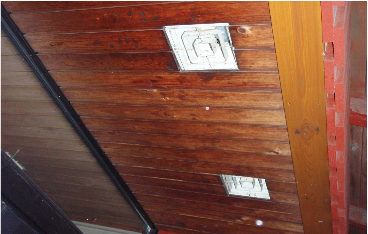
S-kuva 1. Sisäänkäynnin valaistus.
