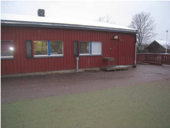
Kuva 1 Sade- ja sulamisvedet ohjautuvat sadevesikaivoihin.
