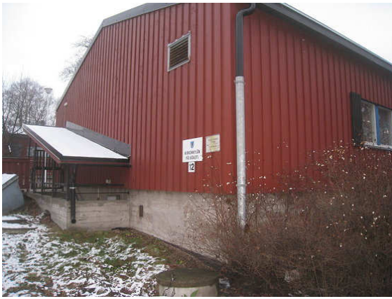
Kuva 5 Länsikulmalla on näkyvillä patolevyä.
