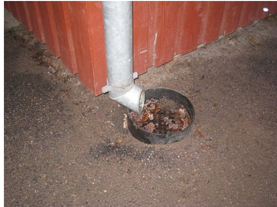
Kuva 2 Sisäpihan puolella kattovedet johdetaan kaivoihin.
