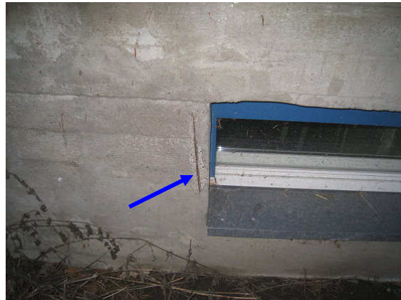
Kuva 4 Ruostunutta raudoitusta.
