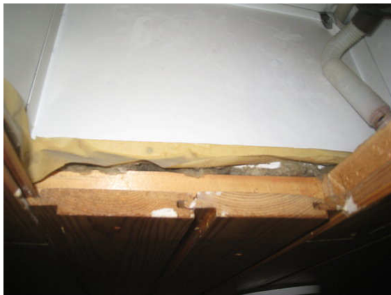
Kuva 19 Valaisinkotelon kohdalla ei ole ilmasulkua.
