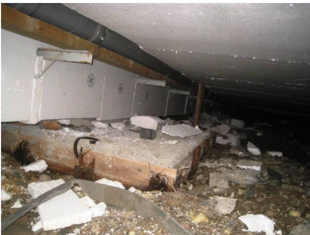
Kuva 18 Viemäriputken tuentaa F-osalla. Anturan muottilaudoitus paikoillaan.
