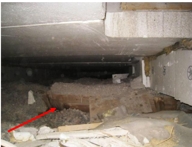
Kuva 1 Teräsbetonianturan muottilauδοitusta paikoillaan B-osalla.
