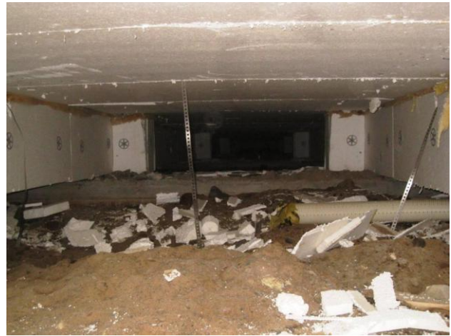
Kuva 17 Salaojaputken pää tukittu muovilla.
