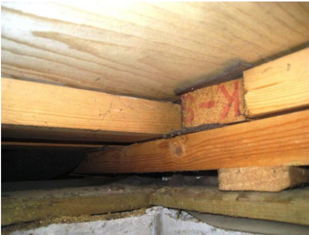
Kuva 5 Salin lattiarakenne nostettu ontelolaatan päältä.
