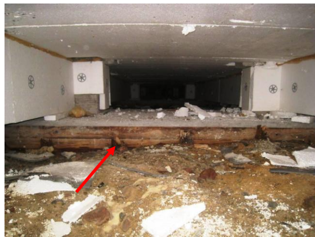
Kuva 2 Teräsbetonianturan muottilauδοitusta paikoillaan F-osalla.
