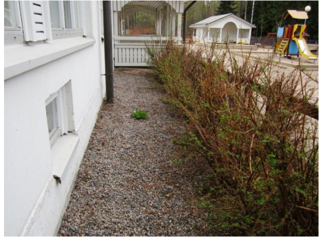
Kuva 2 Rakennusvierustan sepelöintiä.
