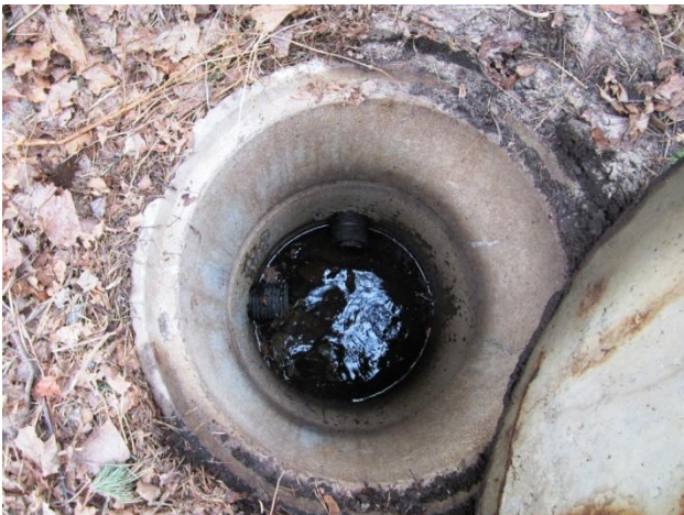
Kuva 13 Salaojaputkien tarkastuskaivo.
