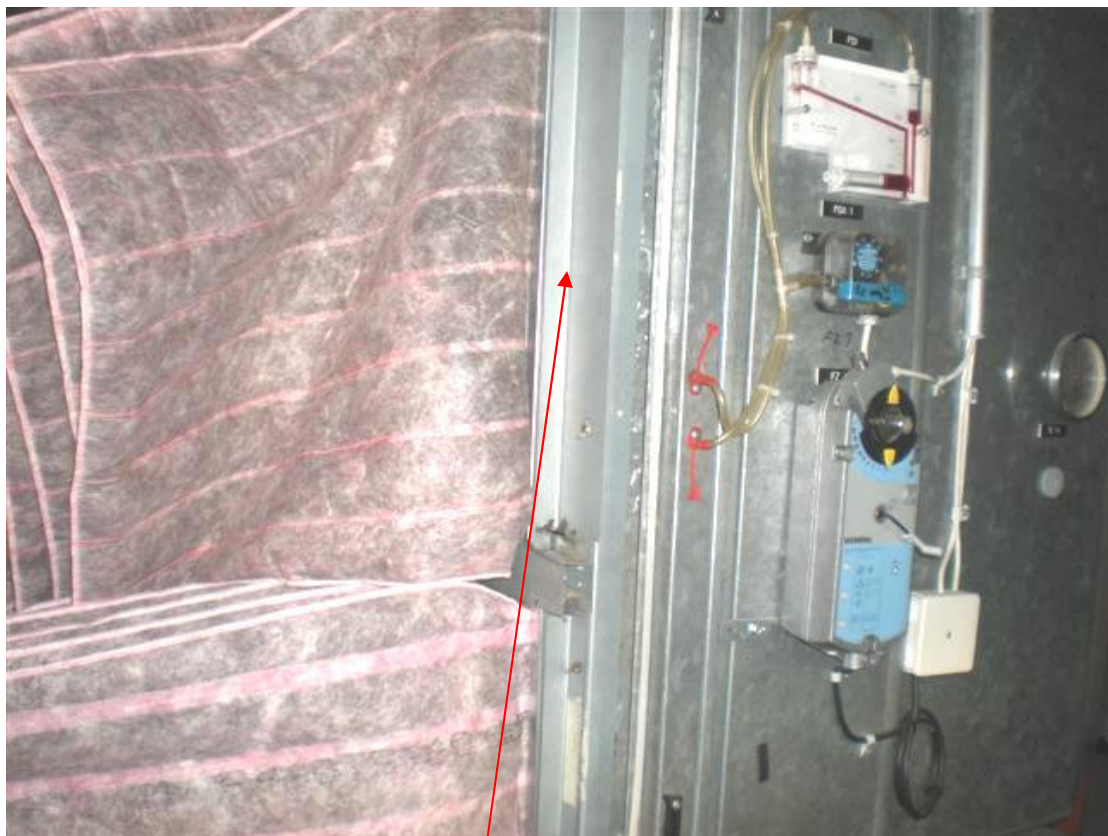
Kuva 4. Tulosuodattimien kiinnityslista.
