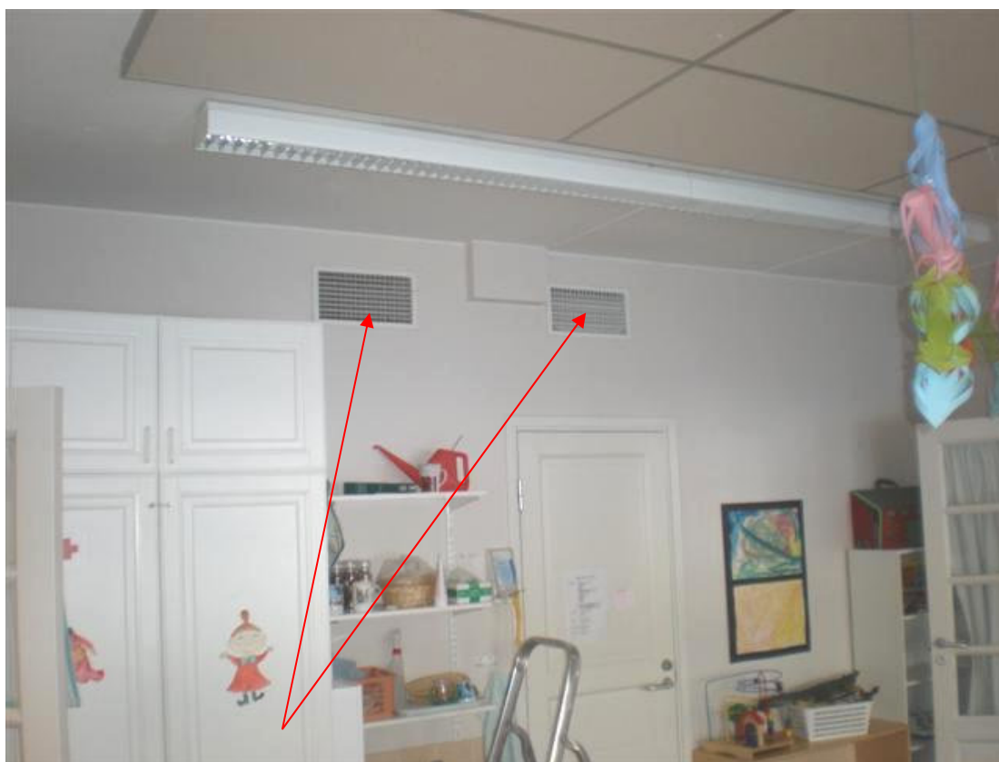
Kuva 5. Tulo- ja poistoilmasäleikkö.
