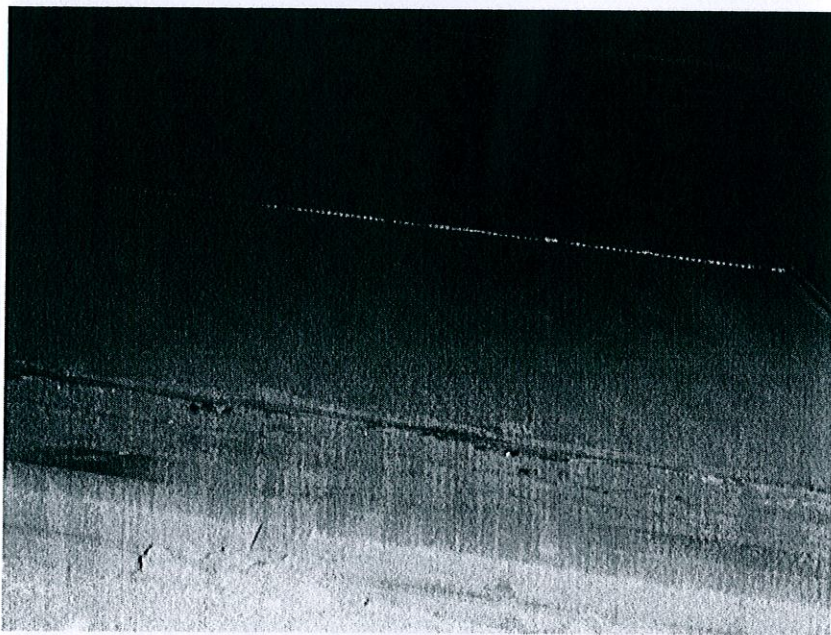
Kuvat 1 ja 2 likaa tuloilmakammioista lähtevässä kanavissa.
