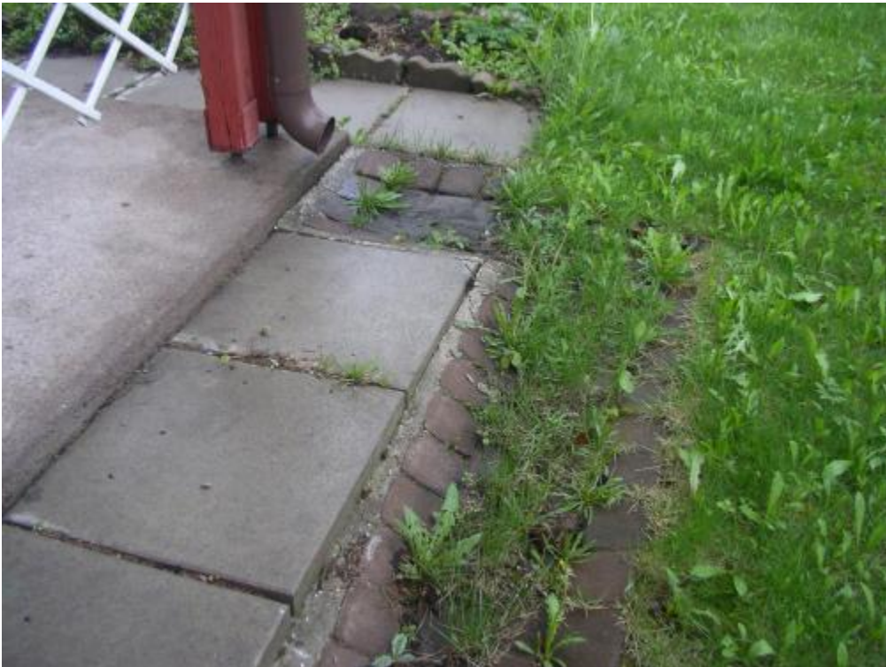
Parvekkeen nurkalla on kattovedet johdettu pintakourulla läheiseen sadevesikaiivoon. Kouru on alkanut kasvaa rikkaruohoa puutteellisen huollon vuoksi.
