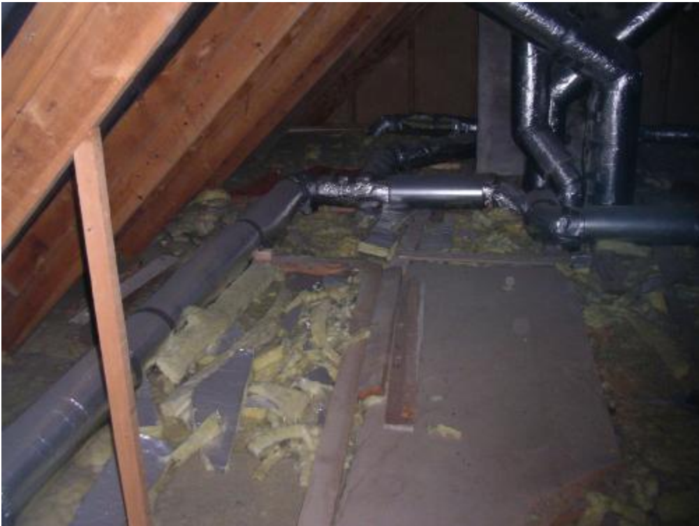
Yleiskuva ullakolta, jonka keskiosalla on runsaasti ilmatilaa
