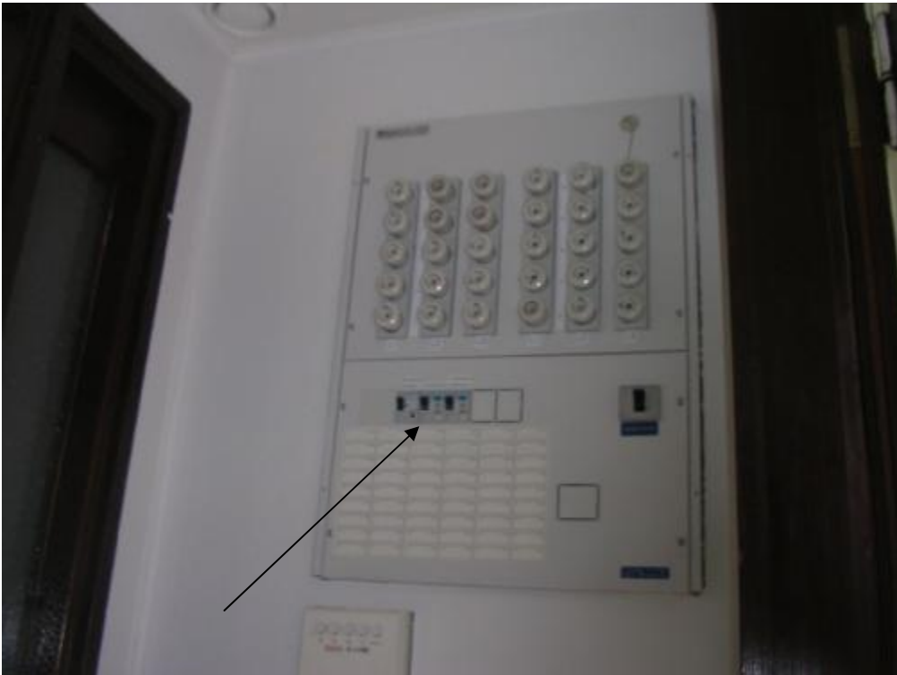
Sähkötaluun on lisätty vikavirtasuojia
