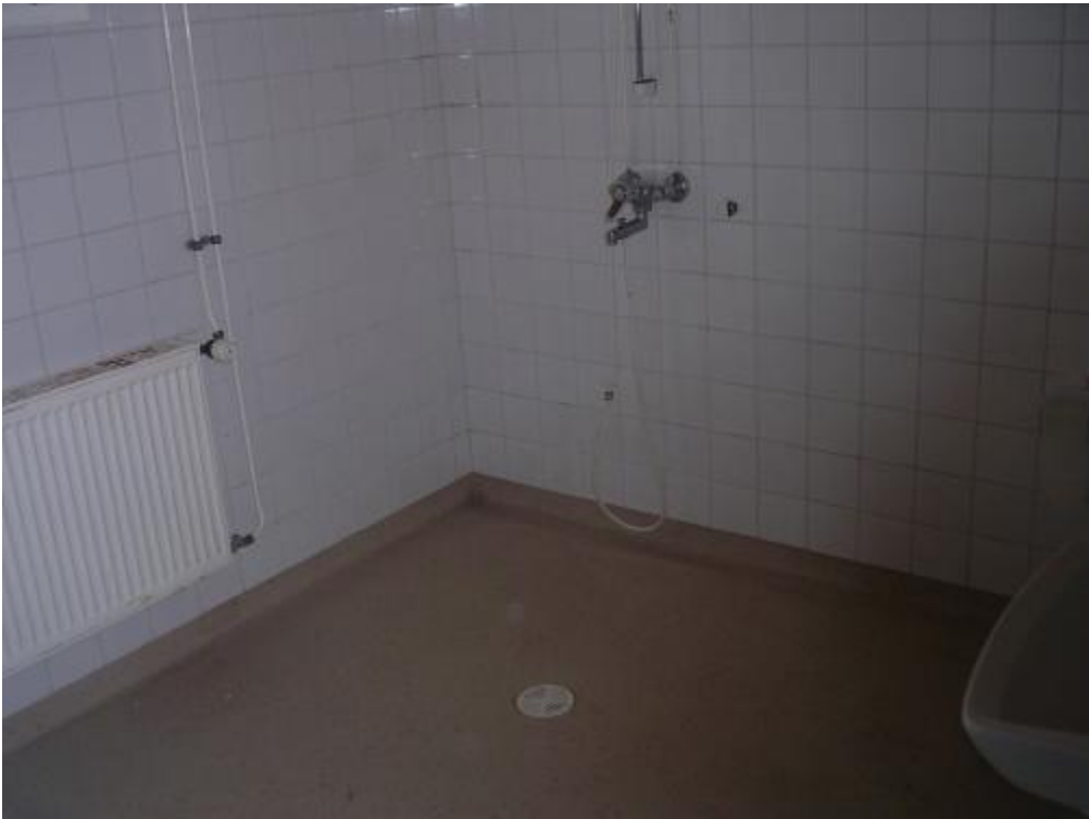
Alakerran pesuhuonetta, jossa on muovimatto lattiassa ja laatoitetut seinät
