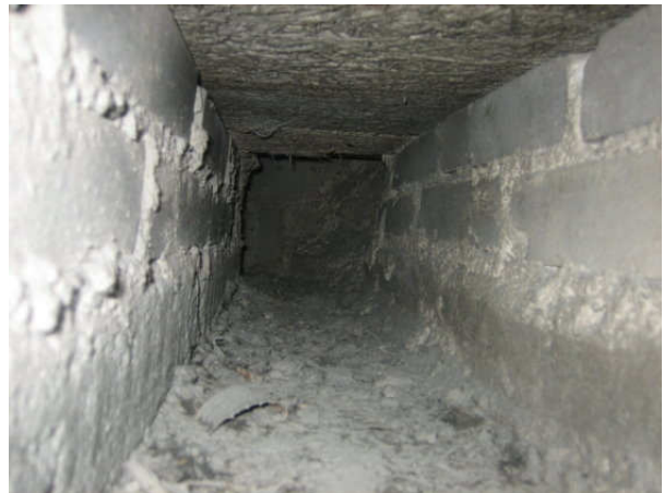
Kuva 8 Kanavan sisällä on muurausta ja katossa on sementtilastulevy.
