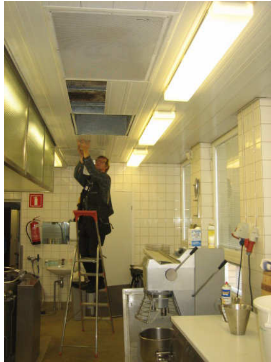
Kuva 2 Vuotokohdan paikallistamisen takia säleikkö poistettiin, samoin alakaton peltilamelleja.
