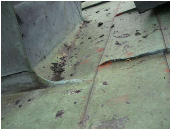
Kuva 13 Kuparipeltikate on ehjä..
