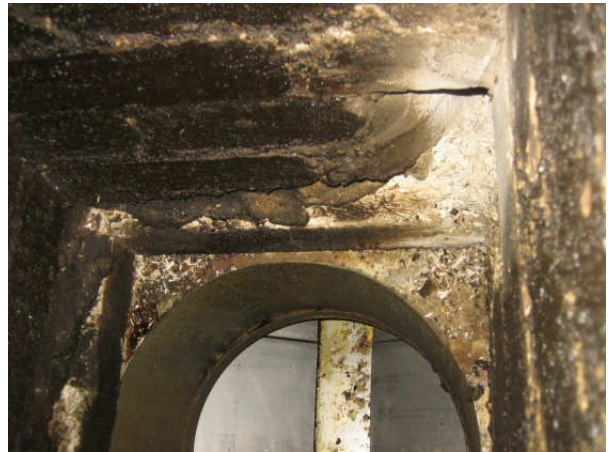
Kuva 20 Huuvan päällä IV-piipun kylkeen on aukot vanhoista poistokanavista.
