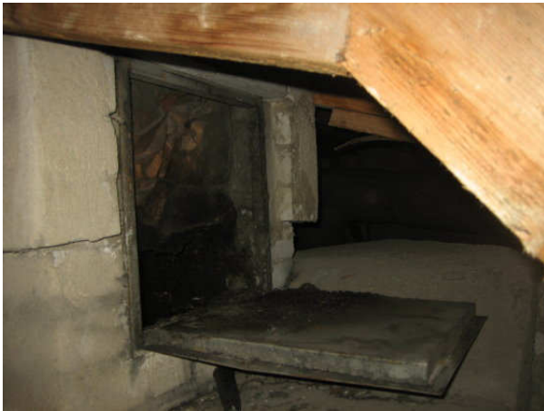
Kuva 19 IV-piipun räystäaskyljessä oleva tarkastusluukku.
