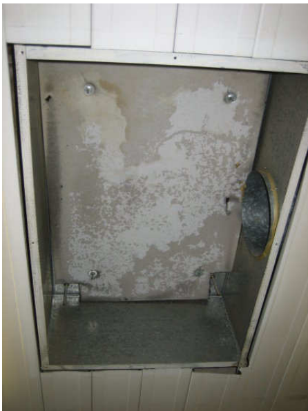
Kuva 3 Vuotokohdalla olevan peltikotelon yläpinnan vaimennusvilla oli märkä ja kotelon päällä oli vettä..
