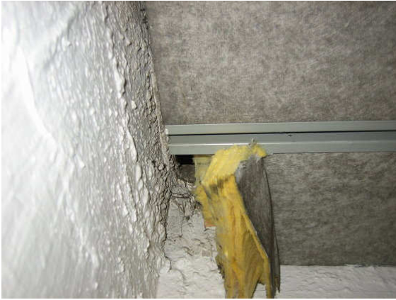
Kuva 7 Vuorivillakattolevyn yläpuolella piilossa oleva hormi. Vieressä poistoilmakanavan venttiili, joka hidastaa ilmavirtausta ylöspäin.
