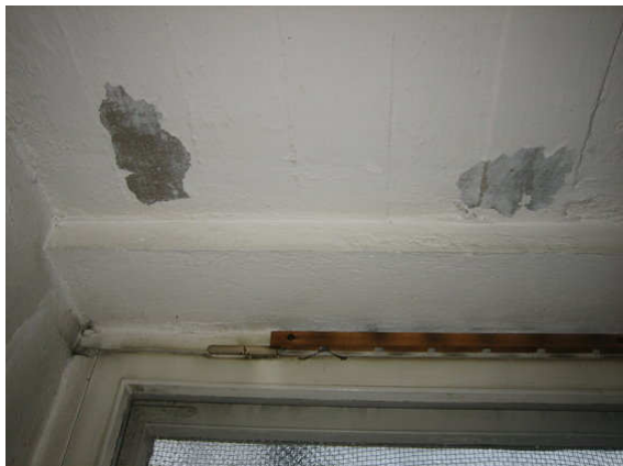
Kuva 12 Rakoveintiileitä on sisäpuoleisissa ikkunoissa.
