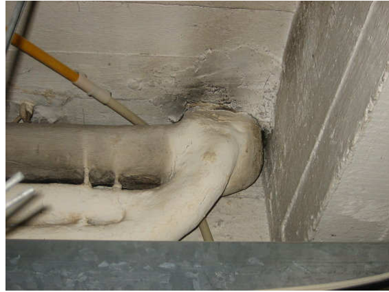
Kuva 8 Tyypillinen kv-putkien läpivienti välipohjassa.
