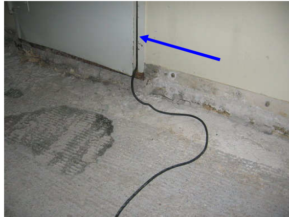
Kuva 4 Palo-oven kautta ilmaa virtaa käytävän suuntaan.
