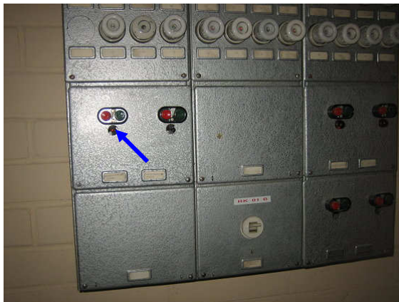
Kuva 11 Huippuimurin ohjaus RK 01B:ssä
