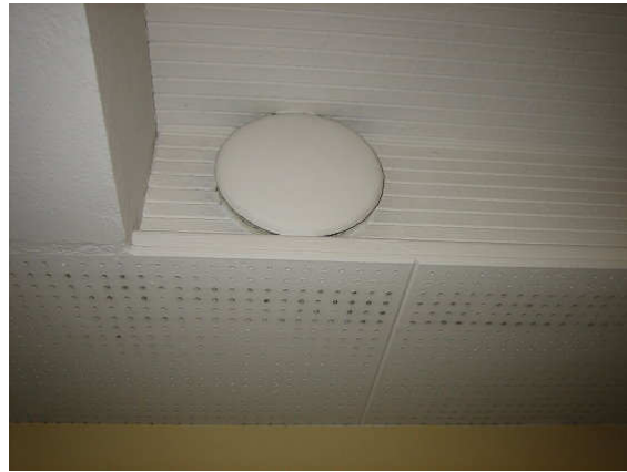
Kuva 14 Eteistilassa on poistoilmaventtiili.
