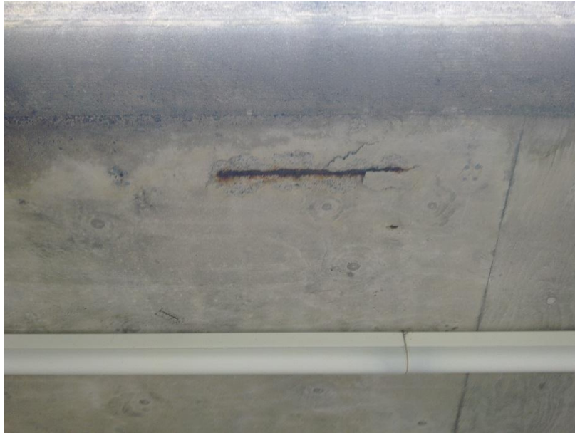
Lipan alaosassa näkyvää ruostunutta raudoitusta
