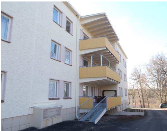
Kuvaa rakennuksen ulkoseinistä ja parvekkeista.
