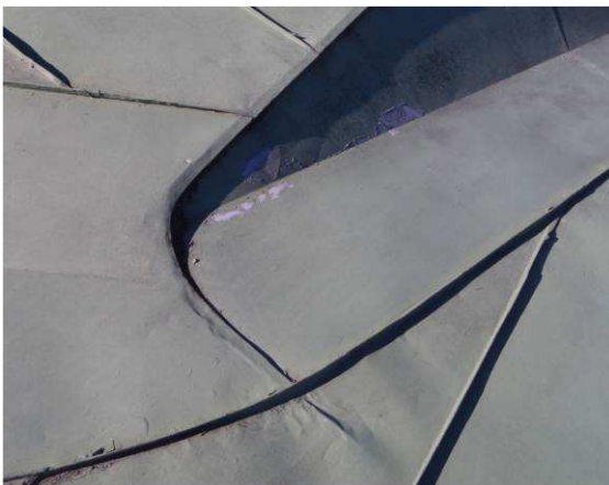
Maalipinta on paikoin irronnut. Katon huoltomaalaus tulee jakson aikana.
