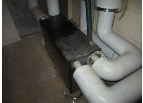
Lämmönsiirtimet on uusittu vuonna 2012.
