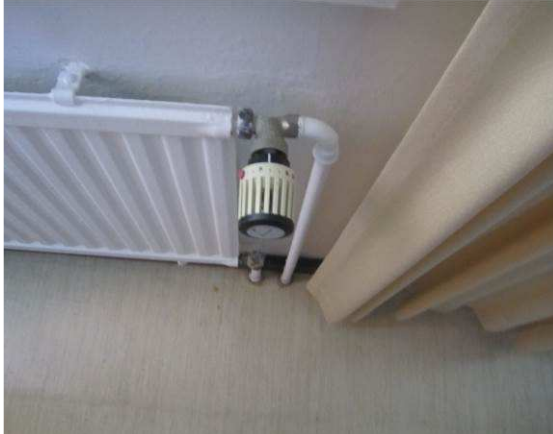
Termostaattinen patteriventtiili
