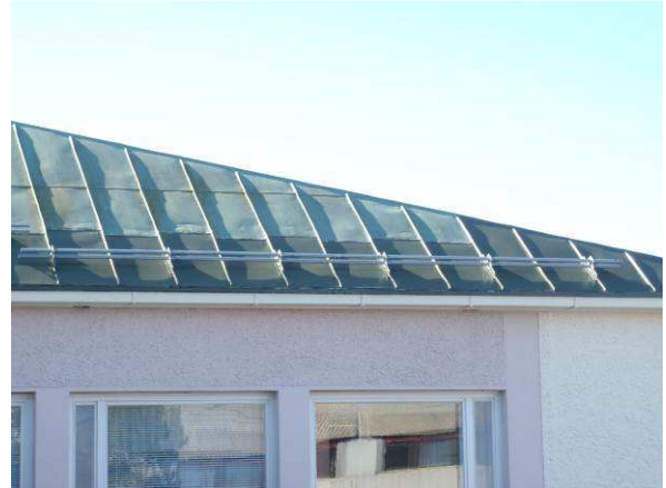
Katetta on uusittu räystäältä vajaa metri. Rännit on uusittuja.
