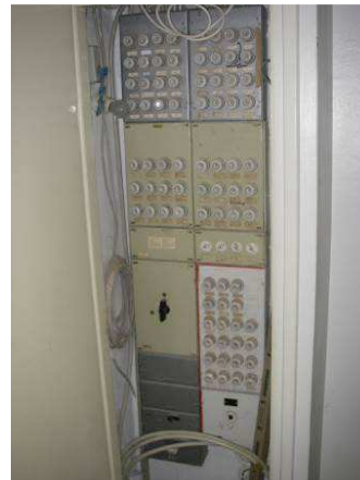
Ryhmäkeskus, mitä on laajennettu useasti.
