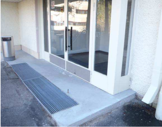
Pääovissa ei havaittu suuria puutteita. Tuuli- kaapin liukuoven mekanismi on menossa uu-
