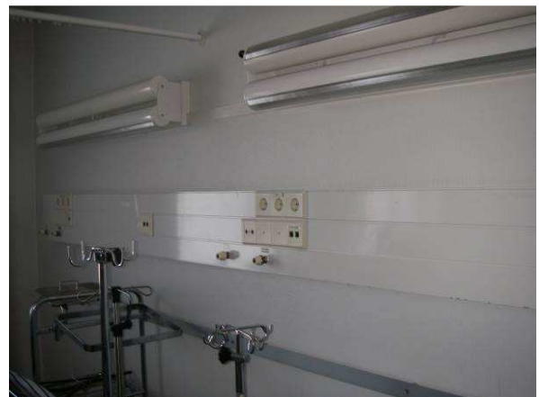
Potilashuoneessa uusittuja sähkökalusteita.
