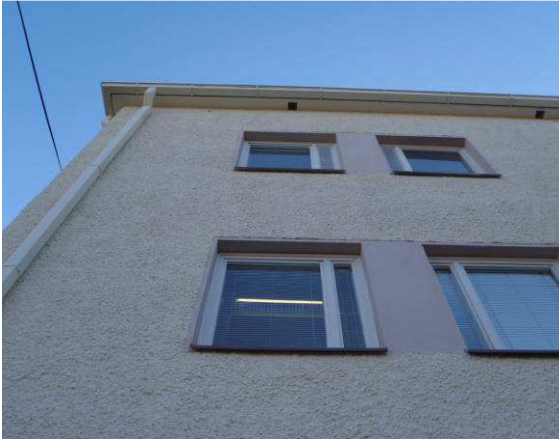
Kuvaa rakennuksen rapatusta ulkoseinäpinnasta. Räystäällä näkyy yläpohjan tuuletus aukot.
