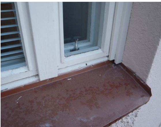
Ikkunat ovat huoltomaalattuja ja vesipellit ovat uusittuja.
