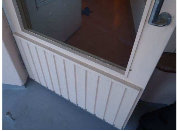
Parvekkeiden puuovet on kunnostettu 2012.
