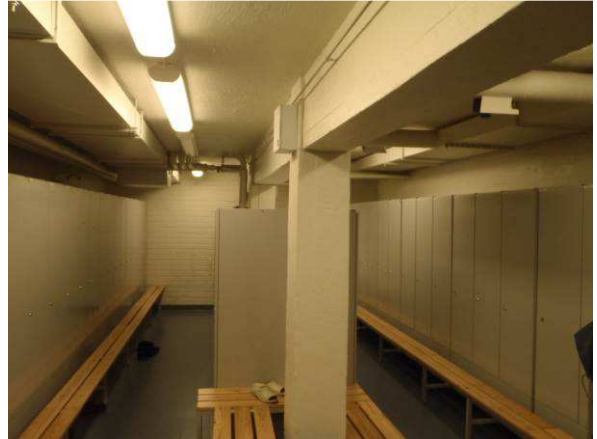
Kellarin betonirakenteissa ei havaittu korjattavaa.
