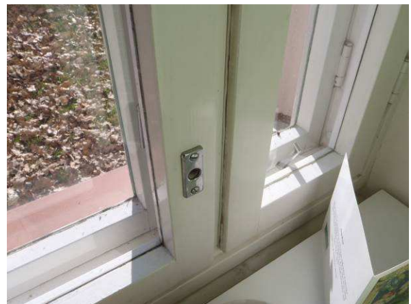
Ikkunat ovat vielä tyydyttävässä kunnossa.
