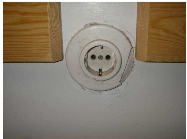
Alkuperäinen pistorasia on rikki.
