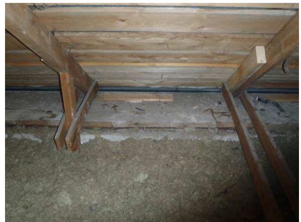
Yläpohjan rakenteissa ei havaittu puutteita.
