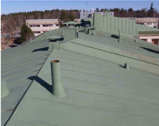
Katto on monimuotoinen. Siellä ei ole kattosiltoja.
