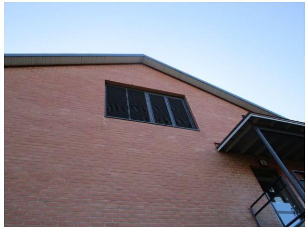
Lumisieppari puuttuu
