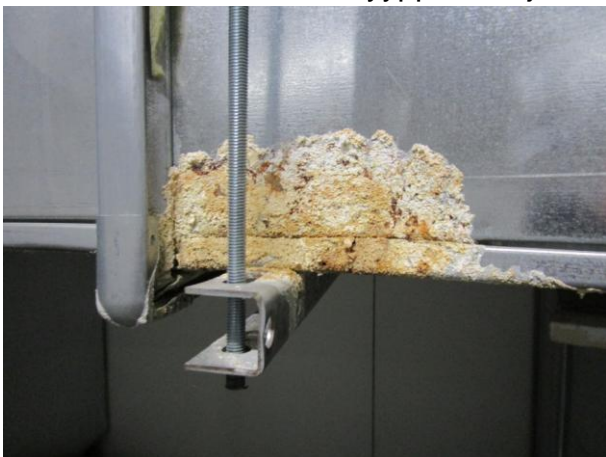
IV-kanavaan pääsee lunta / vettä. Aukealta tuulen vaikutuksesta ja lumisiepparin puute
