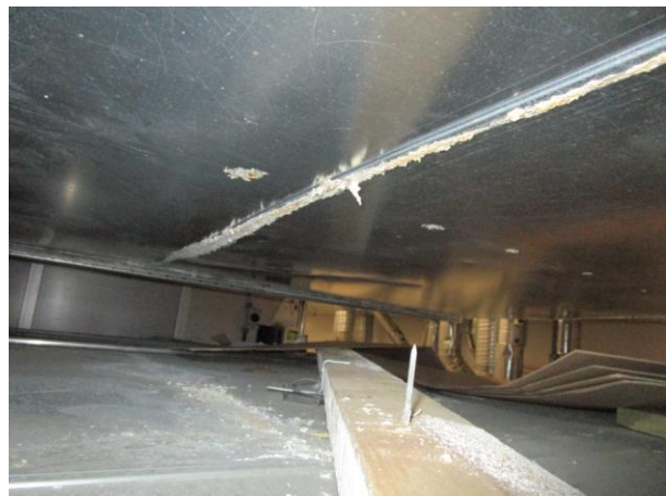
IV-kanavaan pääsee lunta / vettä. Aukealta tuulen vaikutuksesta ja lumisiepparin puute
