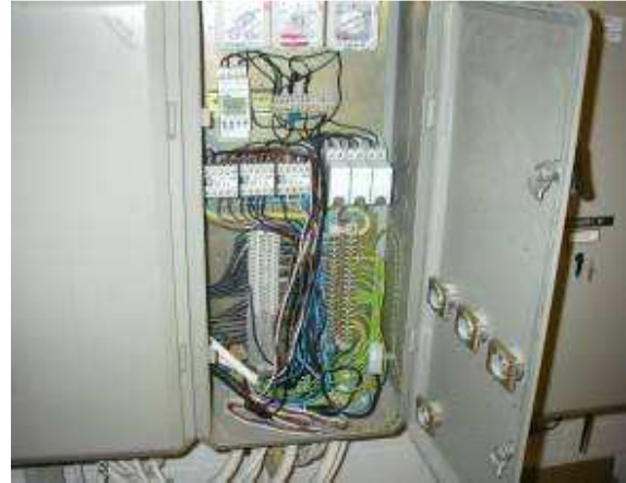
Pääkeskuksen kosketussuojauspuutteita
