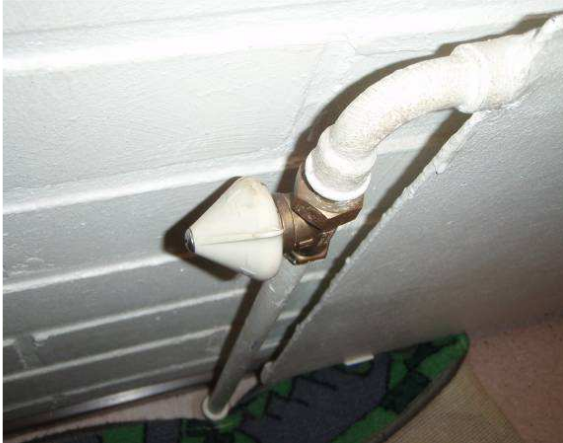
Alkuperäinen patteriventtiili
