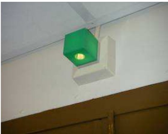
Opasteeton poistumistievalaisin
