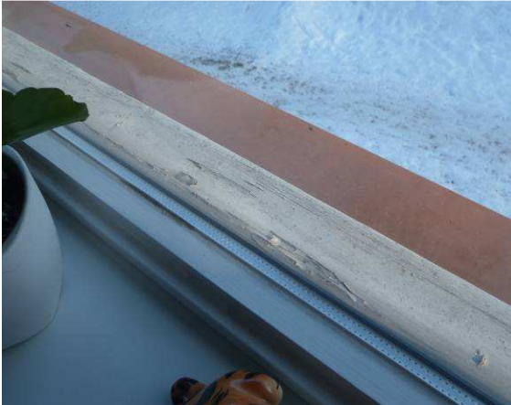
Kohteen ikkunat ovat kiinteitä puuikkunoita.
