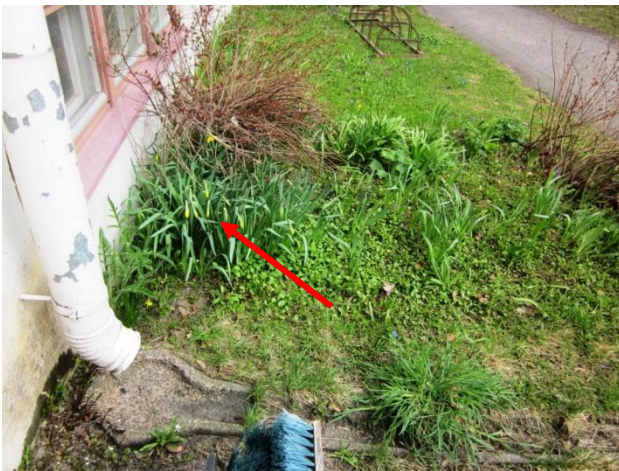
Kuva 3 Kukkapenkin kohdalla maanpinta montulla (osa A).
