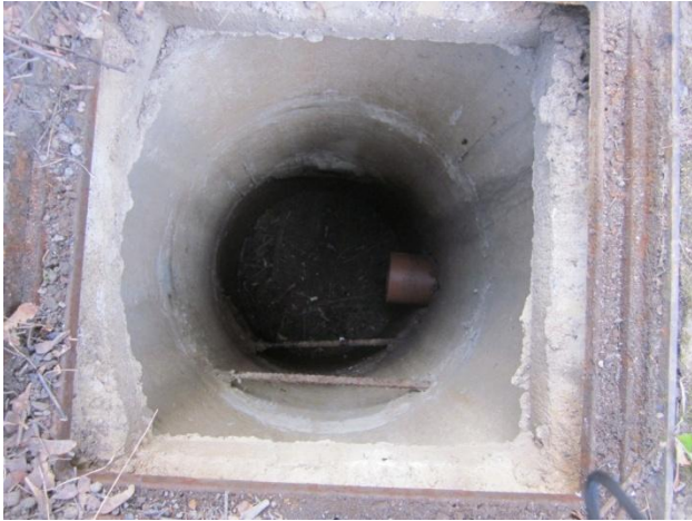
Kuva 15 Salaojaputkien tarkastuskaivo.
