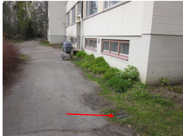
Kuva 2 B-osa ja porrastuksen jälkeen C-osaa. Etualalla ympäriltä heinittynyt sadevesikaivo.
