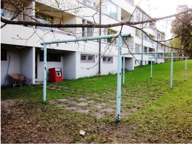
Kuva 12 Kuivaustelineen alue on laatoitettu. Välit ovat heinittyneet.
