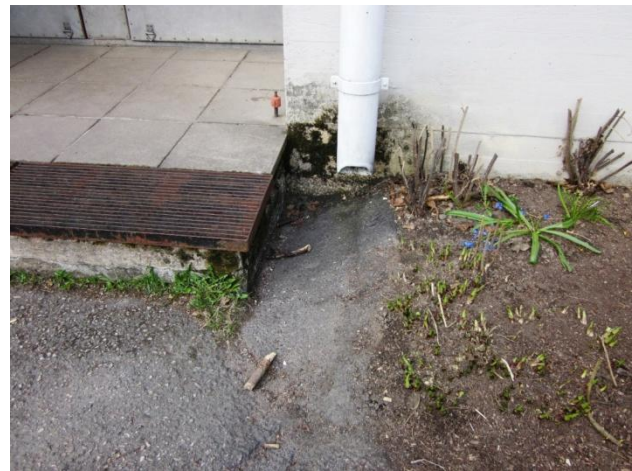
Kuva 4 Syöksytorven alapuolella vettä keräävä monttu (osa C).
