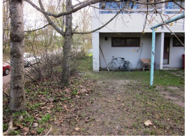
Kuva 13 Luoteiskulmalla maanpinta viettää rakennukseen päin.
