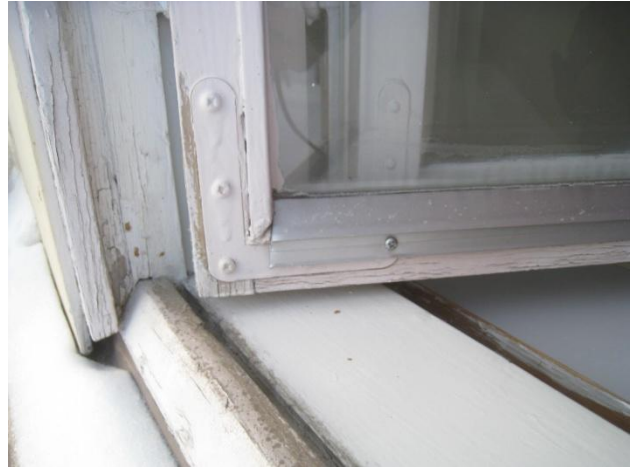
Kuva 9 Ulkopuitteessa alumiinilista suojana.
