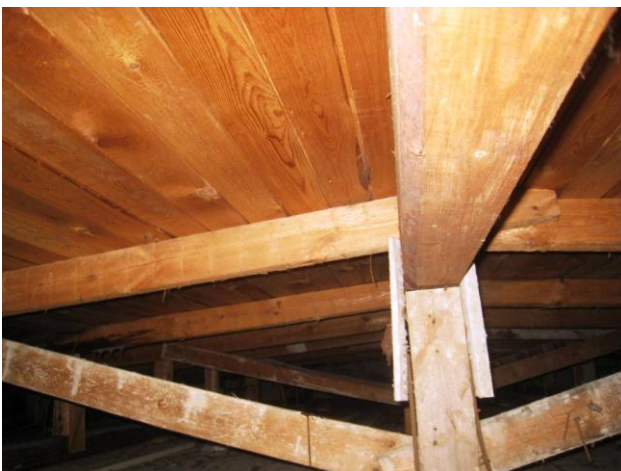
Kuva 4 Kattoluukun kohdalla kattorakenteissa ei havaittu vaurioita.
