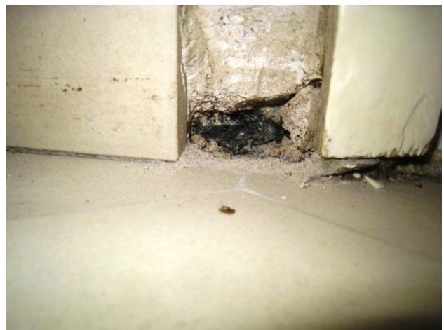
Kuva 5 Kylpyhuoneiden latioissa on vedeneristeenä bitumihuopaa.
