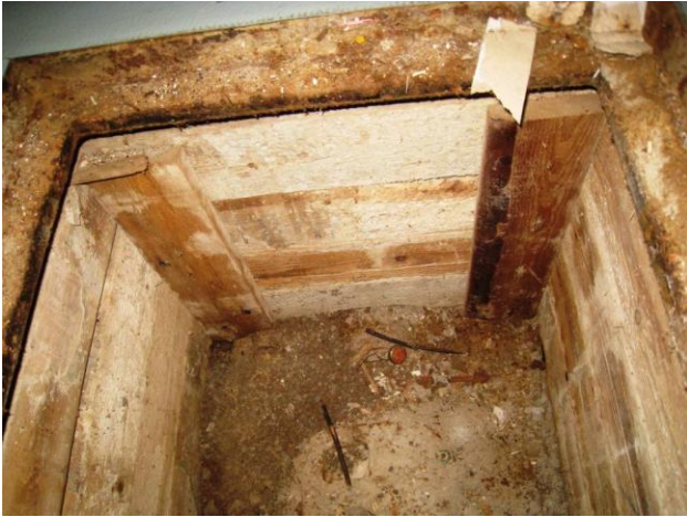
Kuva 3 Muottilaidoitus pohjaviemärin rassaussuukun kohdalla.
