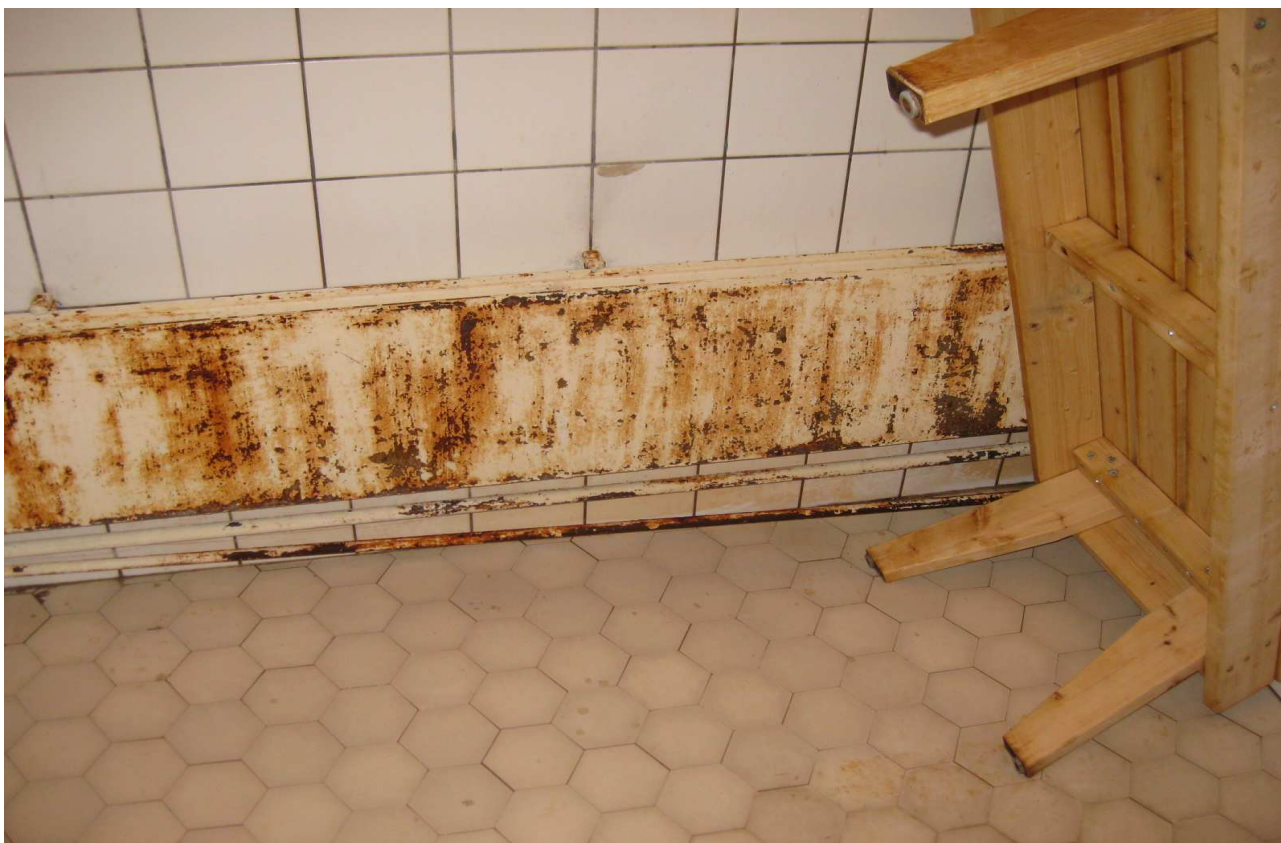
LVI-kuva 7. Yleiskuva saunan pesuhuoneen lämpöpatterista.
