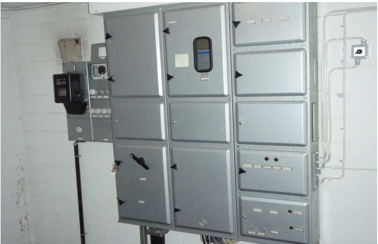
S-kuva 4. Sähköpääkeskus.
