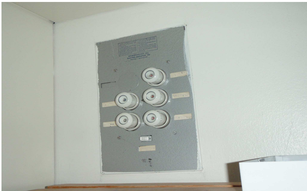
S-kuva 6. Huoneiston keskus.
