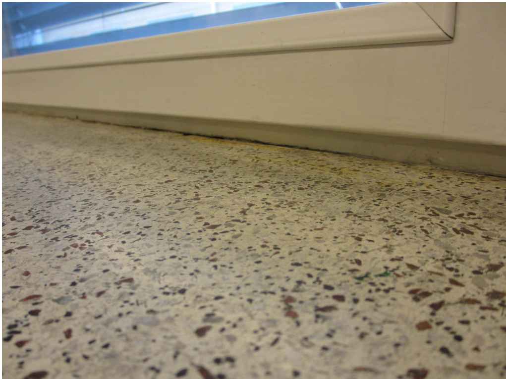
Kuva 1. Ilmavuotoa havaittiin ikkunapenkin ja ikkunan alakarmin liittymästä..
