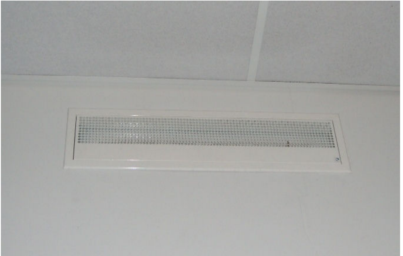
KUVA 9. Yleiskuva seinähajottajasta.
