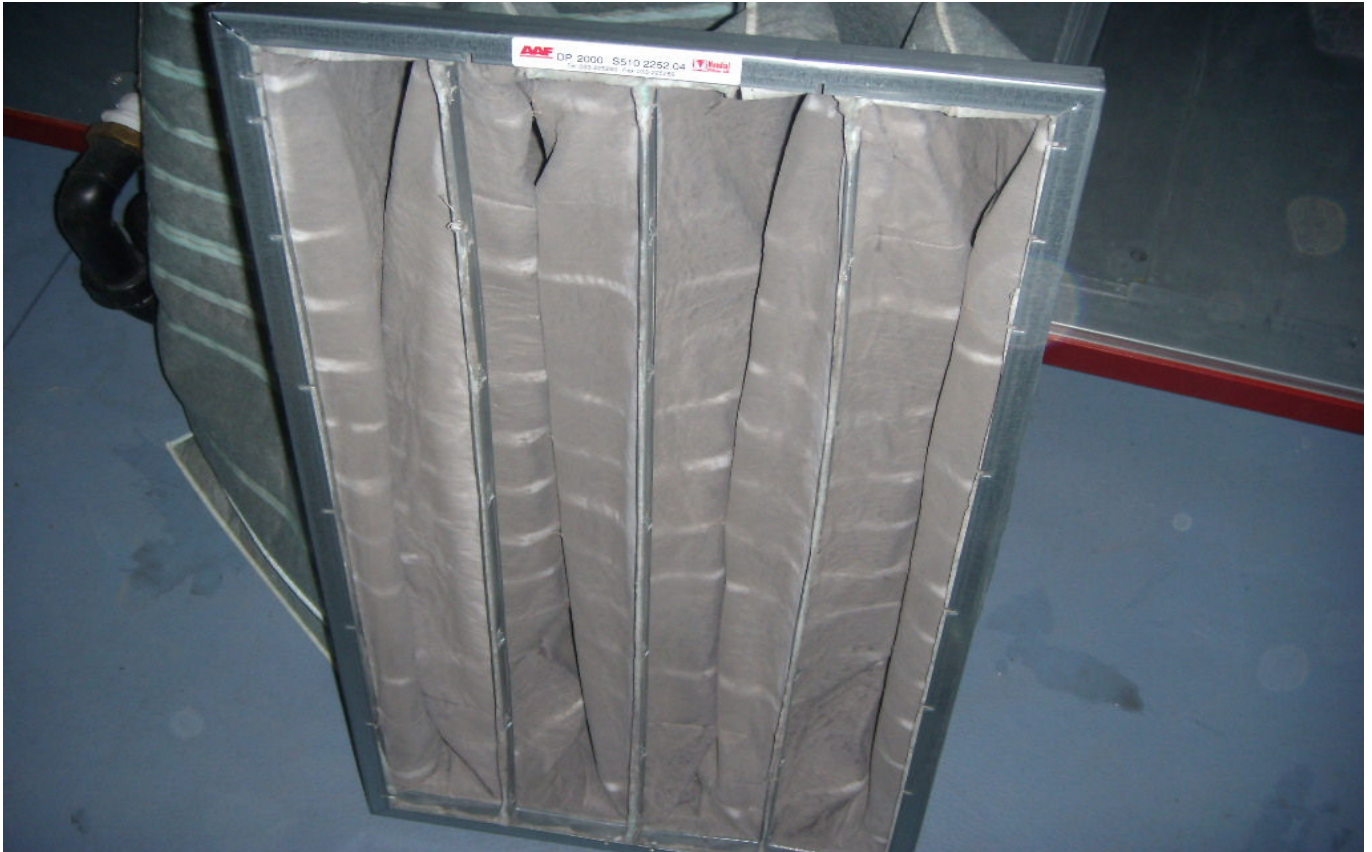
KUVA 5. Yleiskuva poistoilmasuodattimesta.
