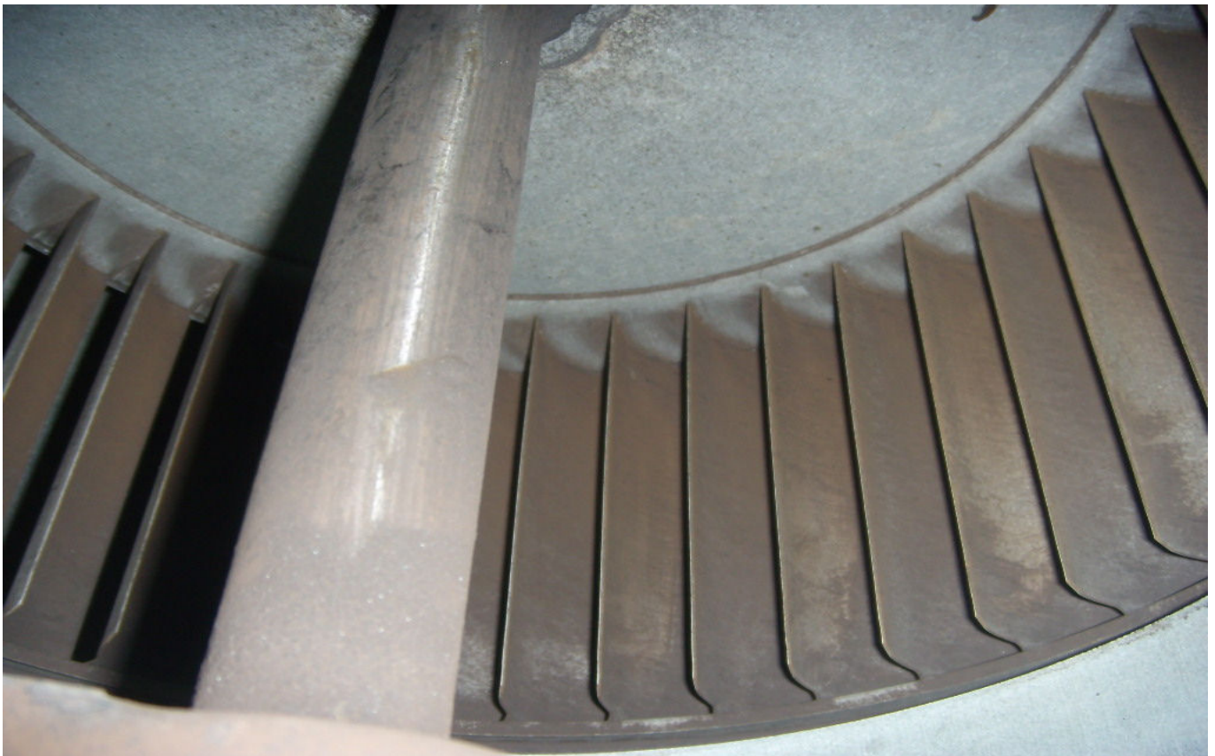
KUVA 6. Yleiskuva poistoilmapuhaltimesta.
