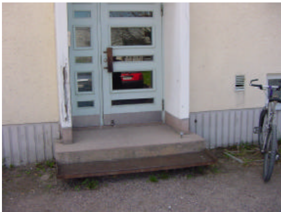
KUVA 9 Ulkoporras ja sokkelin ulkopintaa.(3.2.1.)
