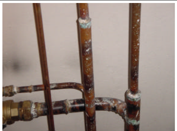
KUVA 24 Messinkijuotoksien sinkinkatoa (4.2.1)
