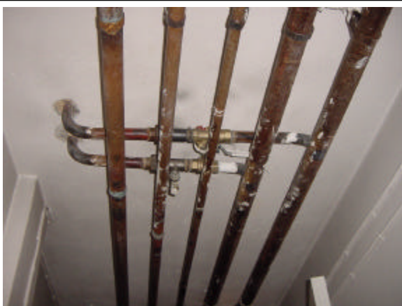
KUVA 23 Putkistoista purettu asbestipitoiset eristeet (4.2.1)
