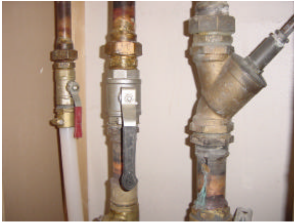
KUVA 25 Vuoto kylmävesiputkessa (4.2.1)
