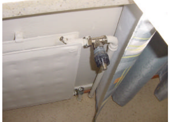
KUVA 22 Termostaattinen patteriventtiili (4.1.4)
