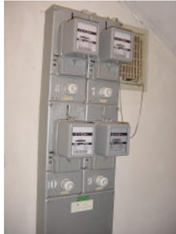
KUVA 32 Yksi huoneistoja palvelevista mittauskeskuksista (5.1.1)
