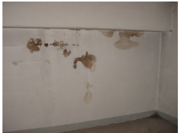
KUVA 16 Vesivaurio mittauskeskushuoneessa (3.3.3.)
