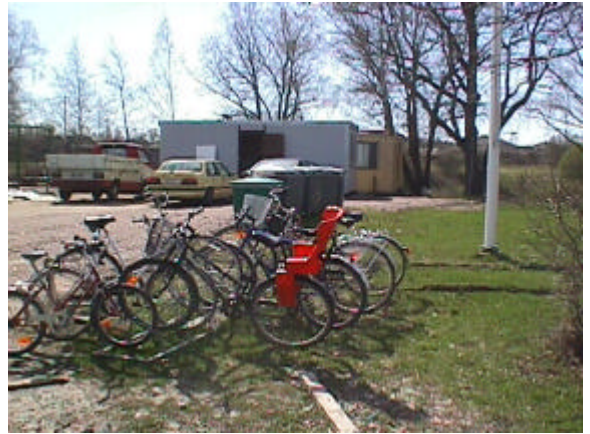
KUVA 8 Jäteastiat, pyöräteline ja rakennusjätettä lippukentällä (3.1.4-5)
