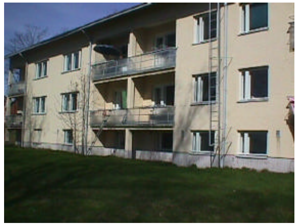
KUVA 2 Rakennuksen seinustalla kasvavia lehtipuita (3.1.1.)
