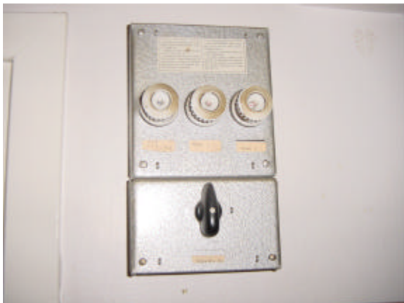
KUVA 33 Yksi huoneistojen ryhmäkeskuksesta (5.1.2).
