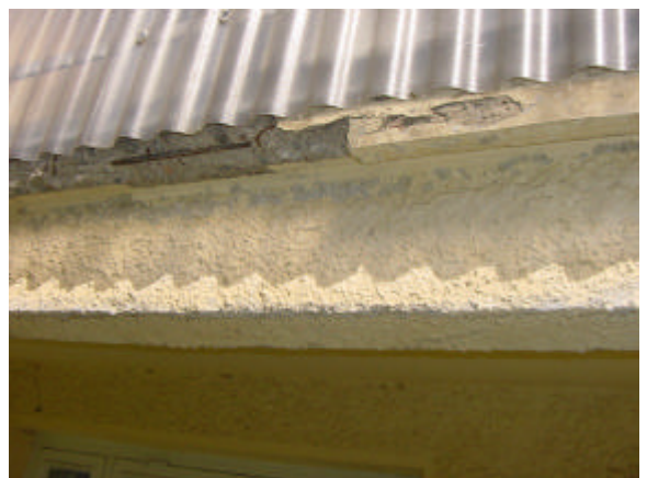
KUVA 12 Vaurioitunut parvekelaatta (3.2.4.)
