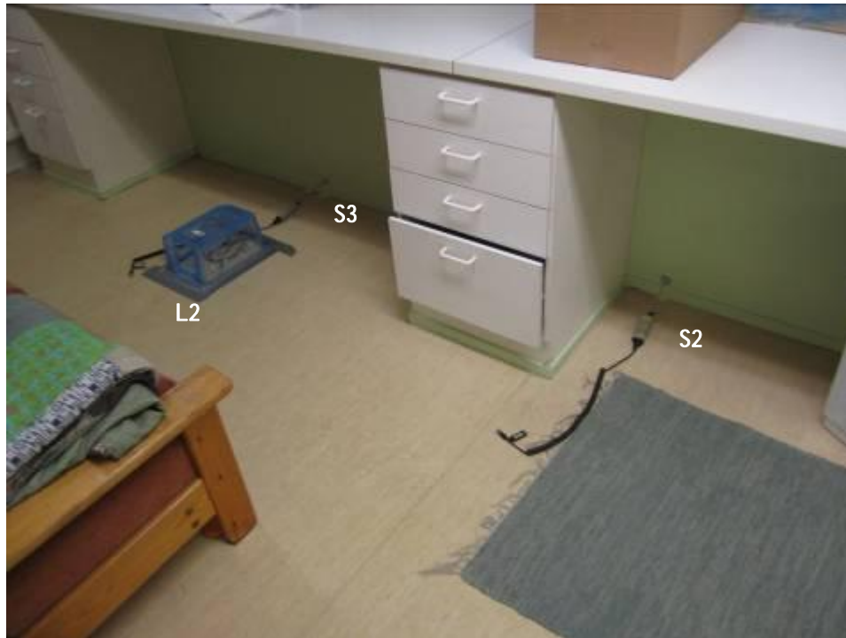
Kuva 12. Esimerkki kevytrakenteisen seinän suhteellisen kosteuden mittauksista tilassa 006. Mittaukset käynnissä mittapisteissä S2 ja S3. Kuvassa on nähtävissä myös lattian porareikämittapiste L2 (suojattu mittauksen ajaksi mittapistesuojalaatikolla).
