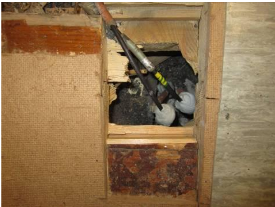
Kuva 11. Esimerkki lattiarakenteen porareikämittauksista. Mittaukset käynnissä mittapisteessä L1.
