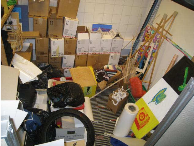
Kuva 37 Kuvaamataitoluokan 1.53 lattian ritiläkaivo on pohjaltaan tomuinen. Varastoidut tavarat estävät tehokkaan siivouksen.
