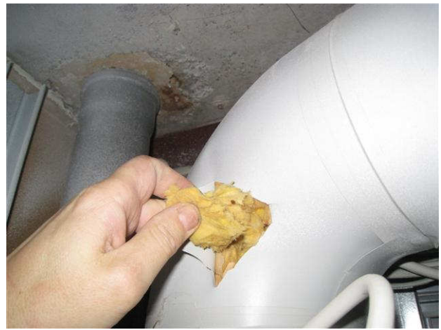
Kuva 14 Solun 2.11 putkikuilun homevaurion syynä on kattosadevesiviemärin kautta tuleva vesi, tässä oleva eriste on märkä.
