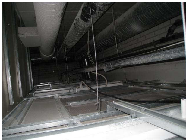
Kuva 39 Yleiskuva kuv.taitoluokan 1.53 alakattotilaan, joka vaikutti olevan kunnossa.
