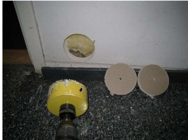
Kuva 28 Käytävän 1.31 kipsilevyseinien materiaalit vaikuttivat terveiltä (AV 1–4).
