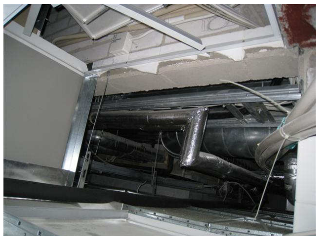
Kuva 42 Keittiön ruuanvalmistustilan ja taustatilojen välissä on yläpohjan/ välipohjan por-
