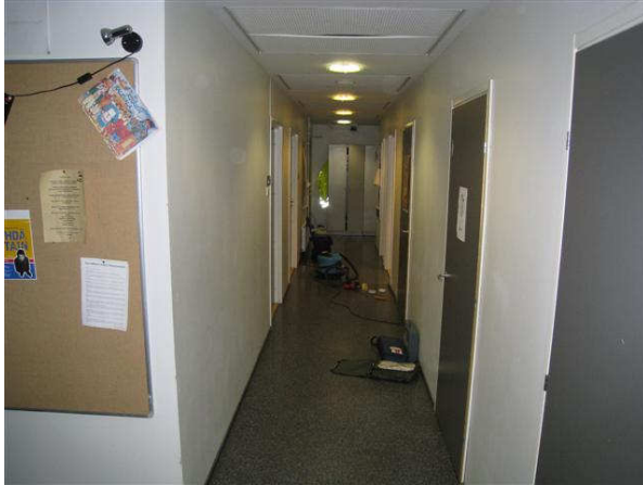
Kuva 25 Yleisnäkymä käytävälle 1.31, jossa ei ole ilmanpoistoventtiiliä, vaan poisto tapahtuu wc-ryhmän kautta huonosti .
