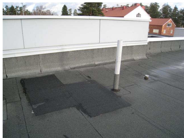
Kuva 2 Paikattua kattuhuopaa, pitkät viemärien tuuletusputket.
