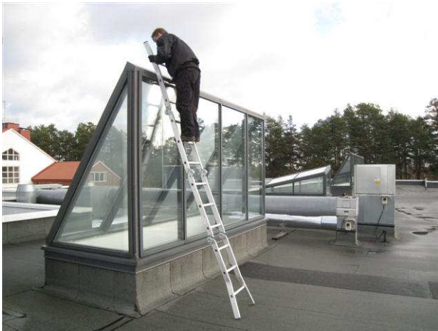
Kuva 3 Kattolyhdyn yläreunan tarkastus solun 2.11 yläpuolella.
