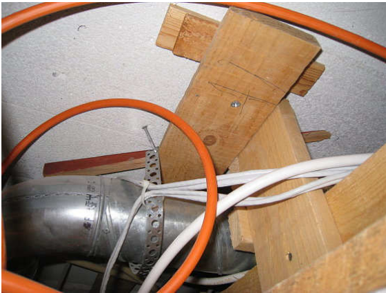
Kuva 9 Käytävän alakaton puukannakkeet ovat kiinni yläpohjarakenteena olevassa kevytbetonilankussa.
