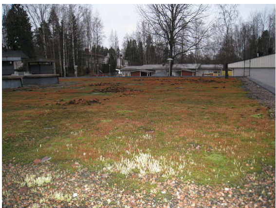
Kuva 6 Vesikatteen pinnalla on runsaasti sammalta yms..
