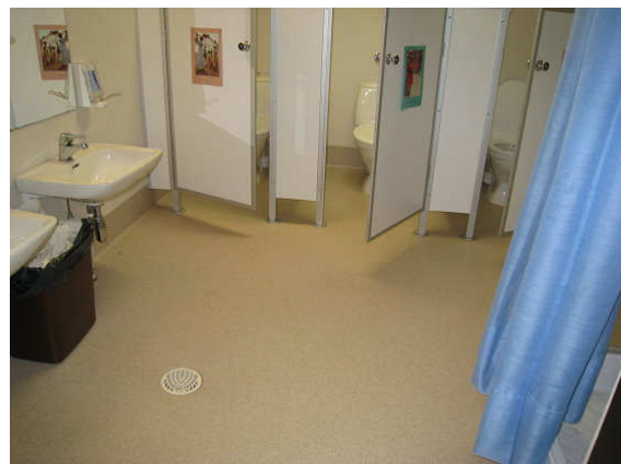
Kuva 12 Lasten WC-/ KPH -tilojen pinnat ovat uusitut.
