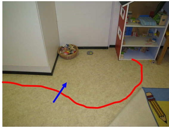
Kuva 16 Lattian pintakosteus on normaalia korkeampi opettajien työhuoneessa.
