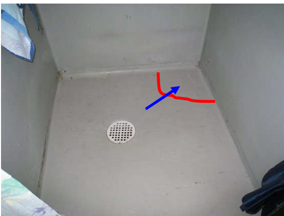
Kuva 11 Lattiasa on normaalia korkeampi pintakosteus.
