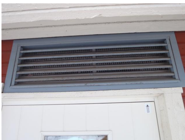
Kuva 3 Raitisilmäsäleikkö on hieman likainen.
