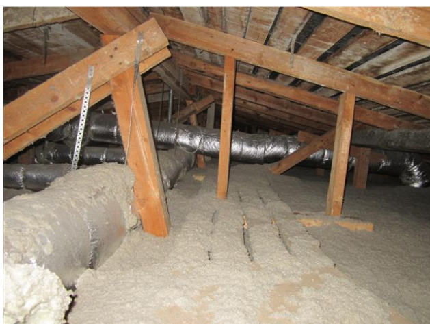
Kuva 5 Poistoilmakanavia yläpohjassa.
