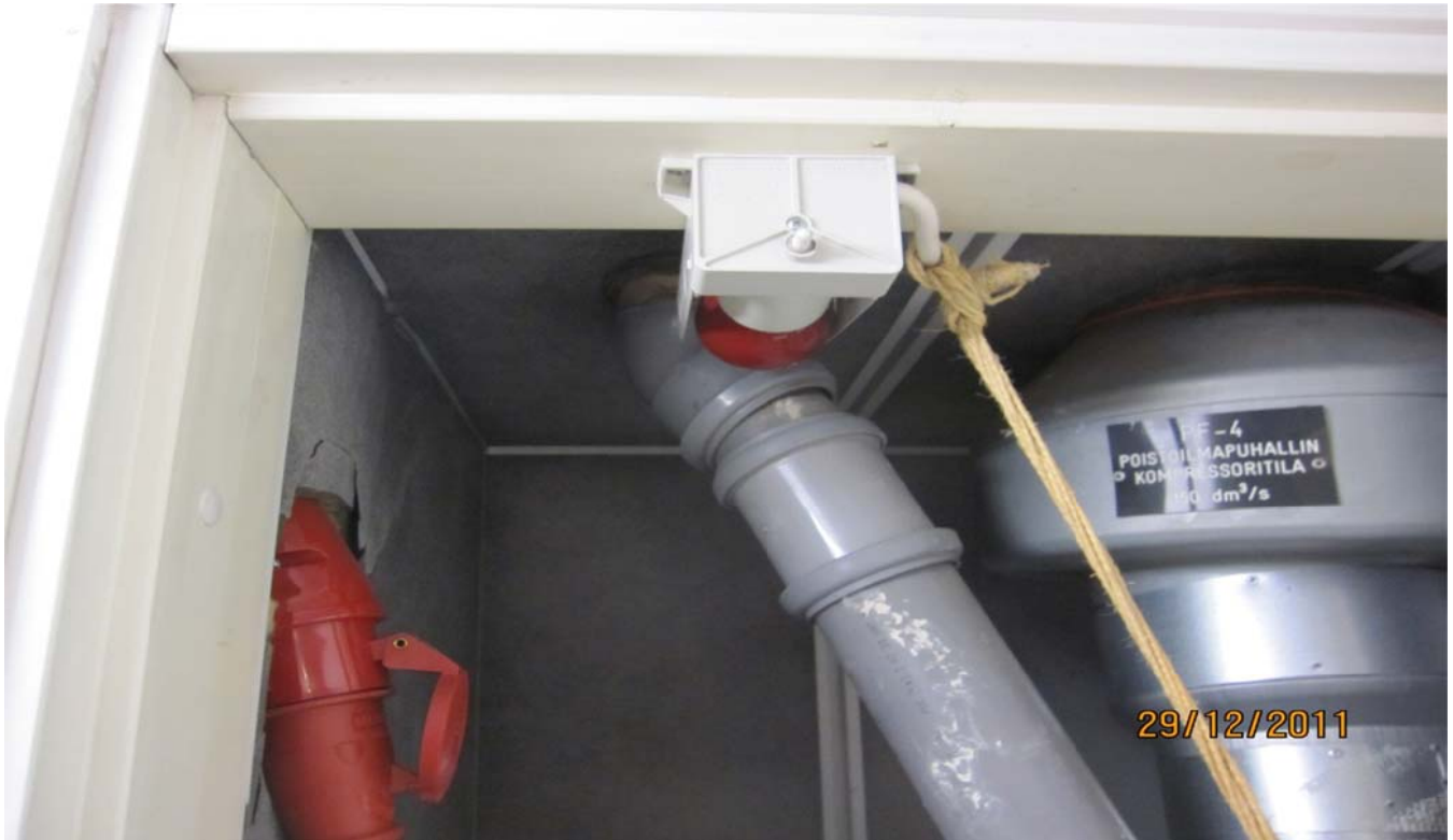
Kuva 1 Suuimurin kannatus sähköjohdosta
