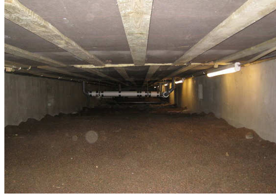
Kuva 2 Lounaan puoleista osaa. Salaojasora kostea.
