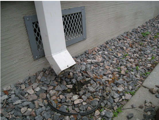
Kuva 15 Sadevesikaivot pihan puoleisella sivustalla sepelin peitossa.
