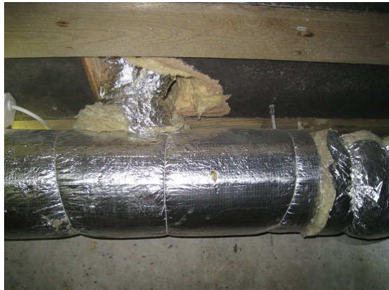
Kuva 12 Tiivistämätön viemäriäpivienti.
