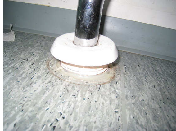
Kuva 14 Viemäriläpivientien kohdilla ei havaittu ilmavuotoja.
