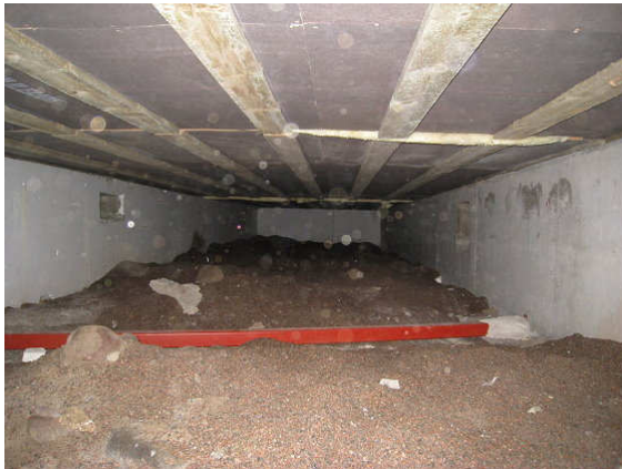
Kuva 3 Täyttökerros on paikoin epätasainen.
