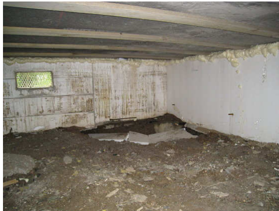
Kuva 11 Polystyreenilevyn alla salaojaputkea.
