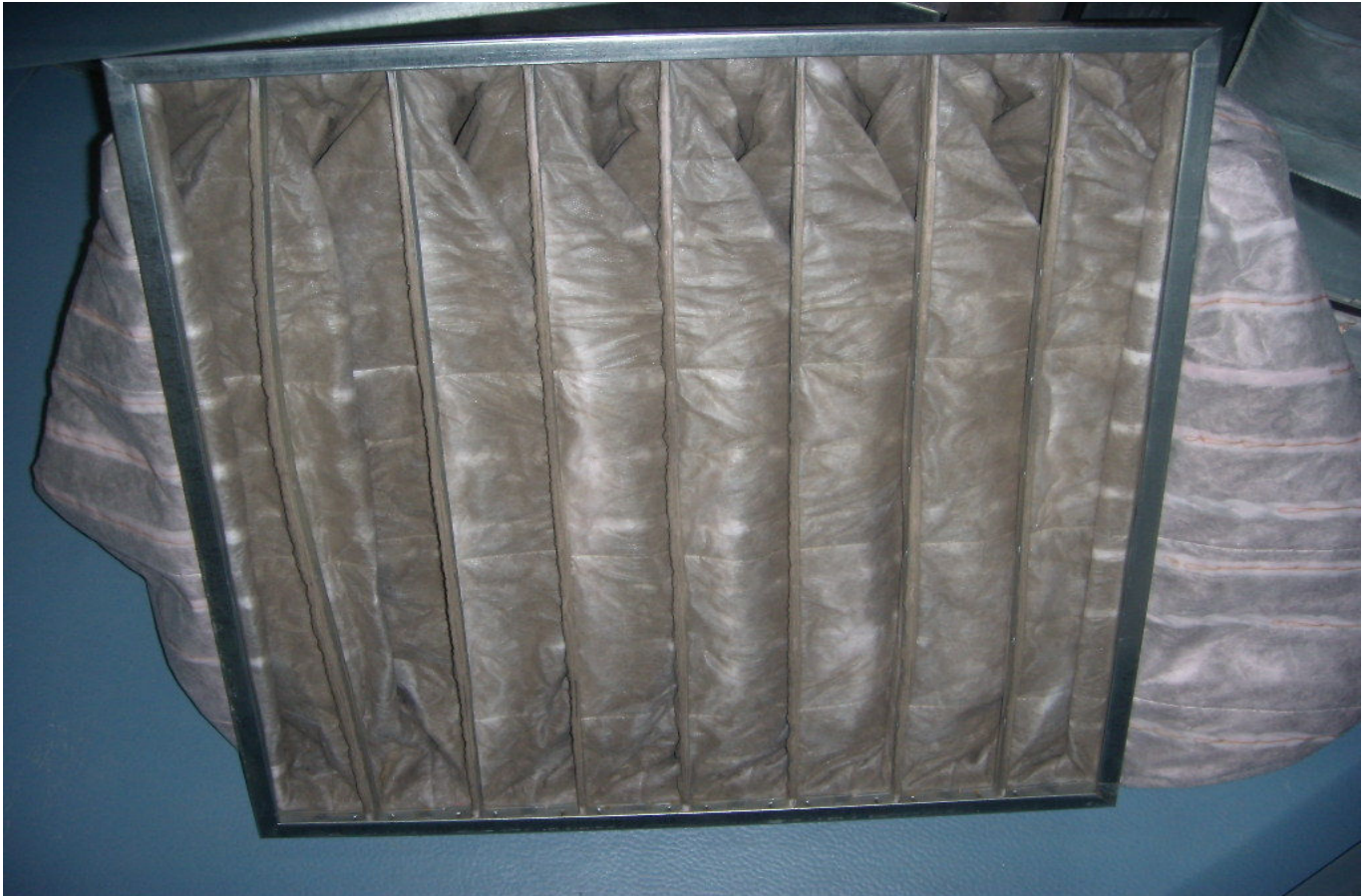
KUVA 15. Yleiskuva tuloilmasuodattimesta.
