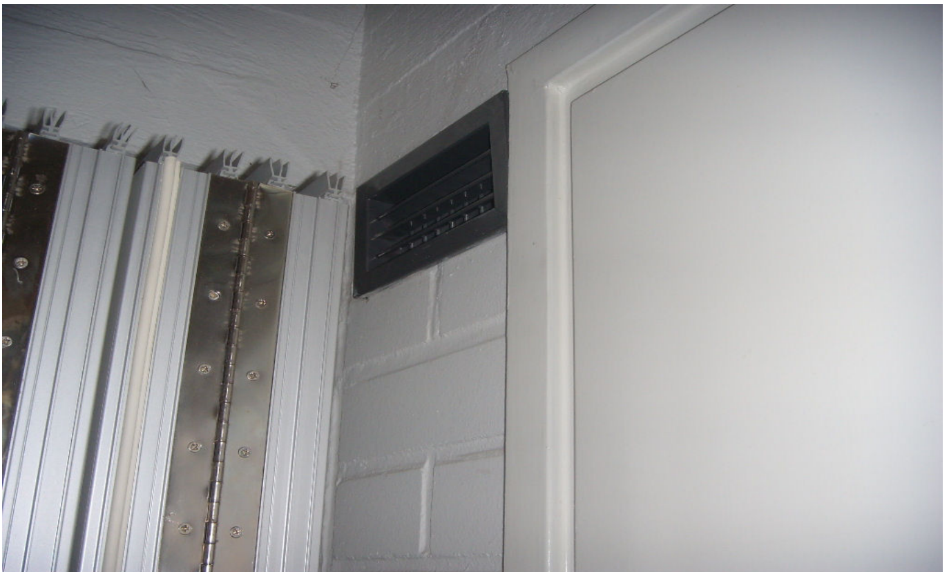
KUVA 26. Heittokuvioiden edessä on väliseinäelementtejä.
