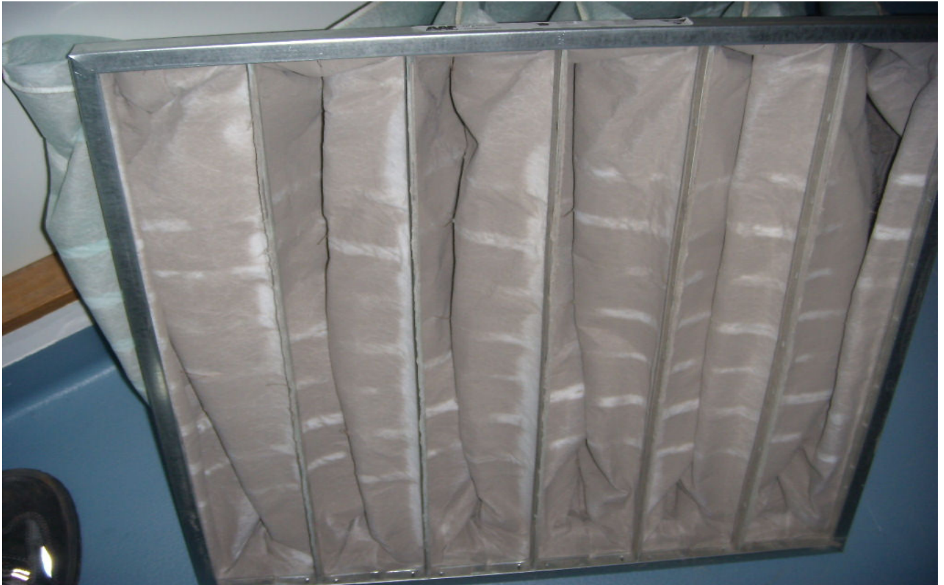
KUVA 17. Yleiskuva poistoilmasuodattimista.
