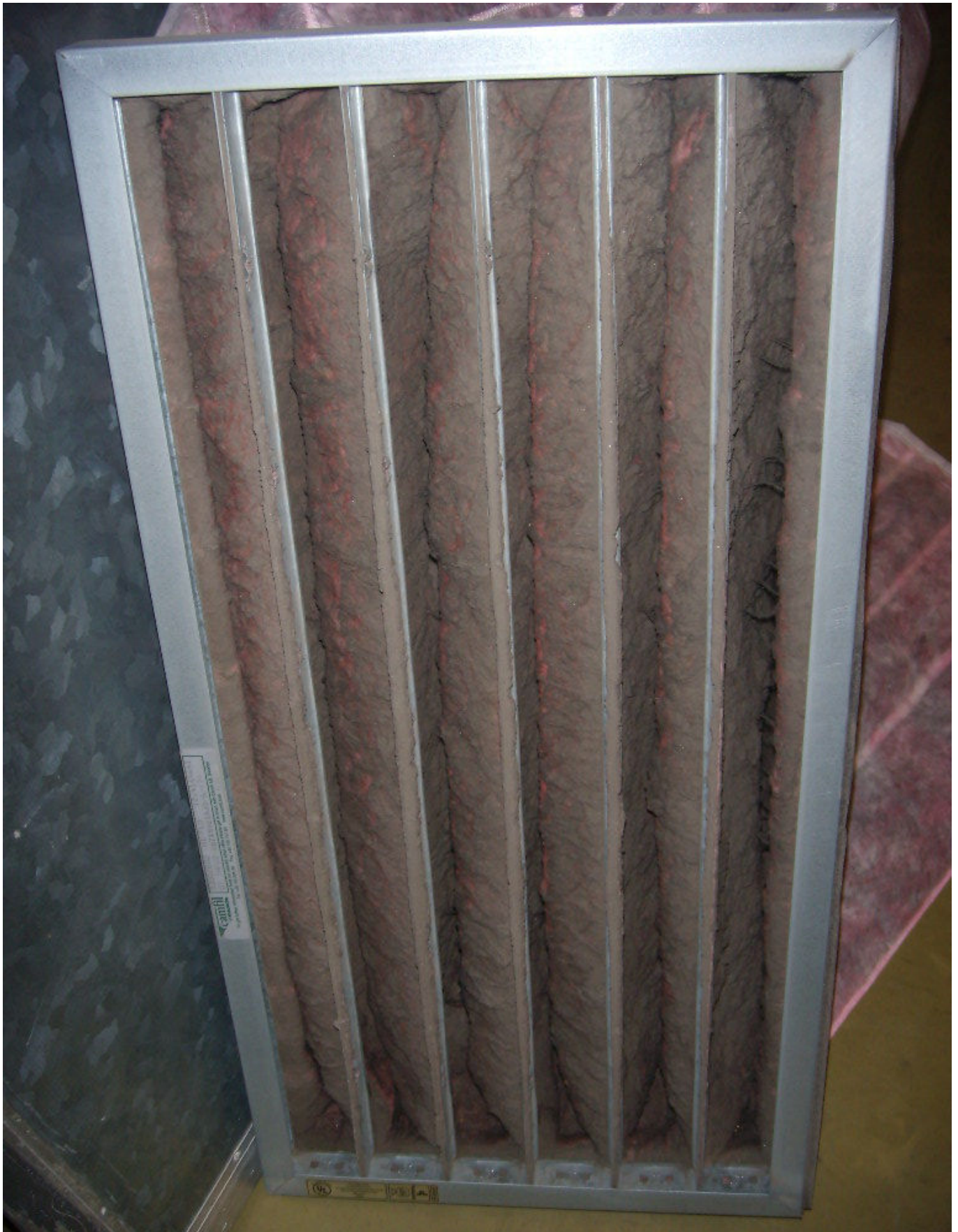
KUVA 8. Yleiskuva tuloilmasuodattimesta.
