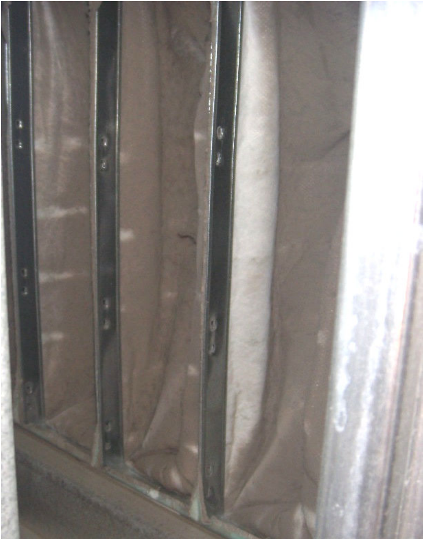
KUVA 7. Yleiskuva poistoilmasuodattimesta.
