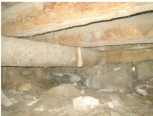
Kuva 1 Sisäänkäynnin puoleisessa päässä oli maapohja roskan peitossa
