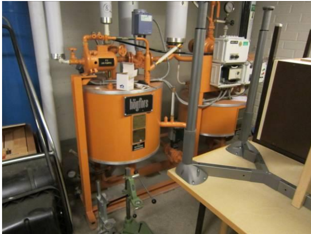
Kuva 17. Kaukolämmön alajakokeskus.
