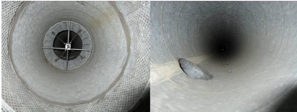
Kuvat 11-12. Yleiskuvat tuloilmakanavasta.
