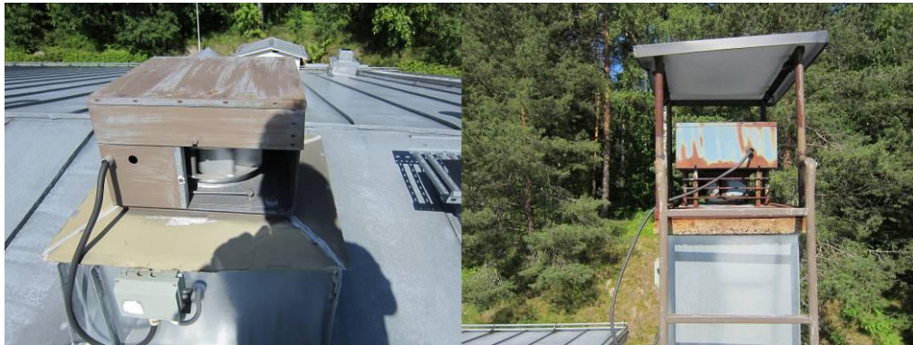
Kuvat 9-10. Yleiskuvat vesikatolta.
