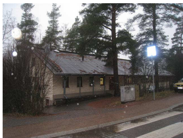
Kuva 2 Yleiskuva Leinikkitieltä pohjoissivulle, maasto viettää etelään.
