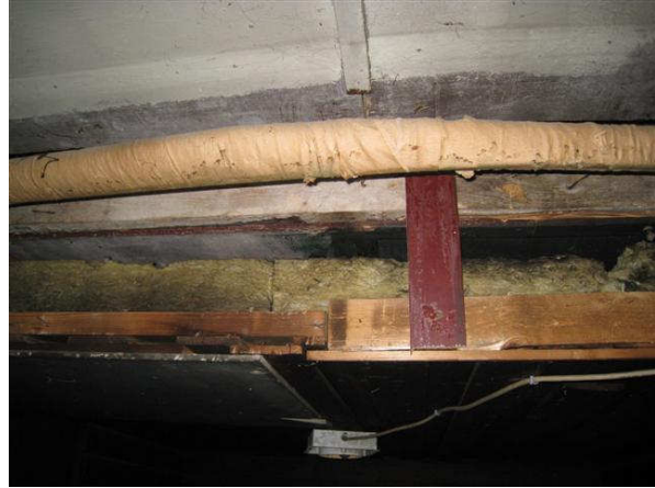
Kuva 52 Huoltorakennuksen yläpohjarakenteita puretun saunan kohdalta.
