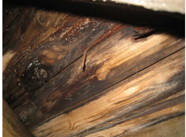
Kuva 22 Luukun sivulla katealusta on märkä ja on jo lahoa puuta.
