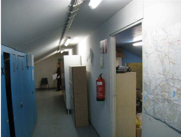
Kuva 45 Yleiskuva ullakon länsiosan käytävältä, jossa viistoa yläpohjaa.
