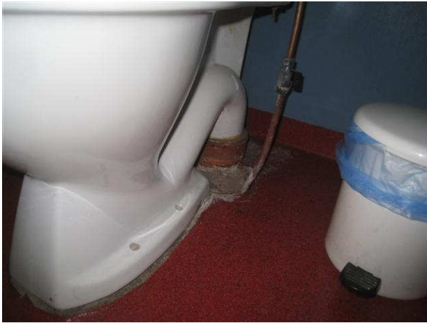
Kuva 41 Wc-pytyn valuliitos ja putki lattiarakenteeseen.
