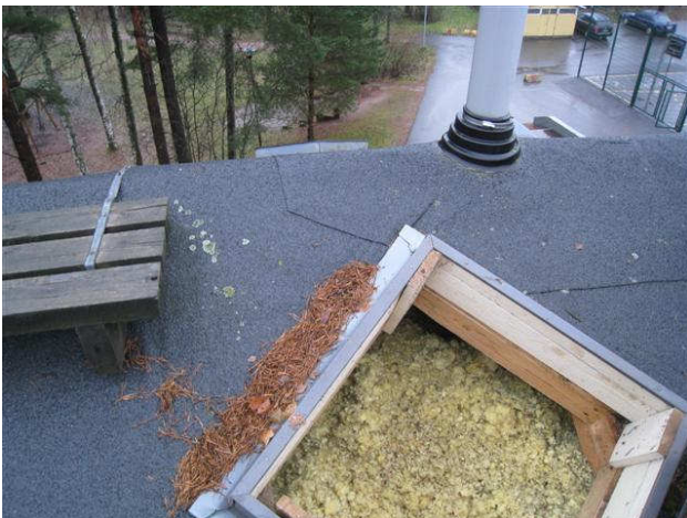
Kuva 19 Länsipäädyn harjan alla oleva luukku, josta tähystettiin.
