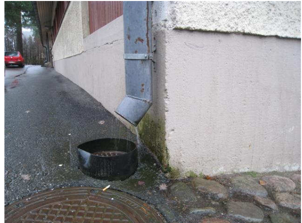
Kuva 4 Rännivesiä valuu ohi
