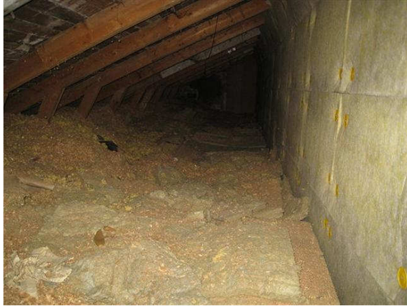
Kuva 33 Etelälappeen sivuonteloa ullakon tasolla itäpäädyssä kohti länsipäätä.
