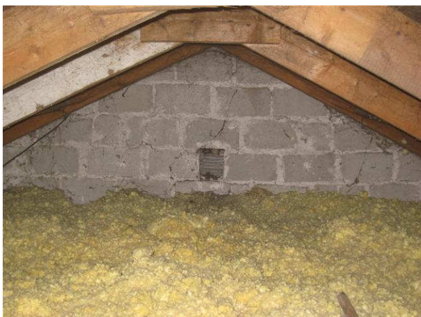
Kuva 25 Itäpäädyn harjaontelon alusta, päädissä on venttiili.
