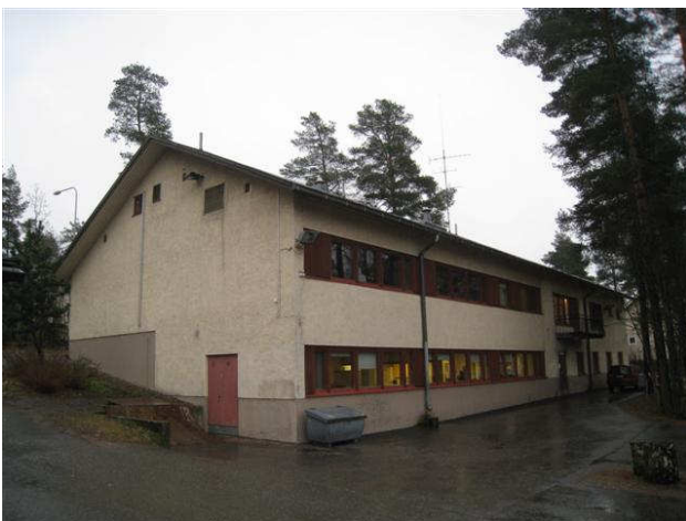
Kuva 1 Yleiskuva päärakennuksen länsipäädystä ja eteläsivulta.
