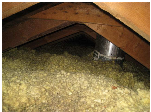
Kuva 20 Länsipäädyn harjan alla oleva ontelotila vaikutti kuivalta.
