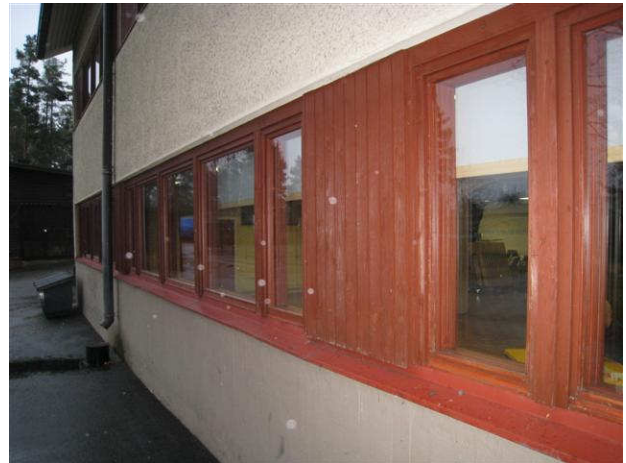
Kuva 6 Yleiskuva eteläsivun julkisivusta
