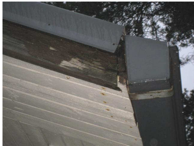
Kuva 10 Lahonnut räystäslauta koilliskulmassa
