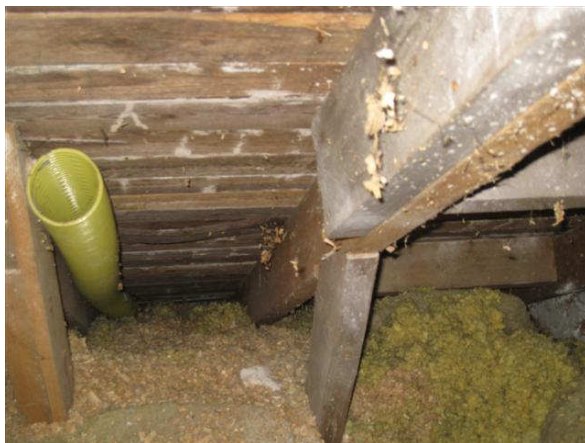
Kuva 31 Sivuentelön tuuletusputkia.
