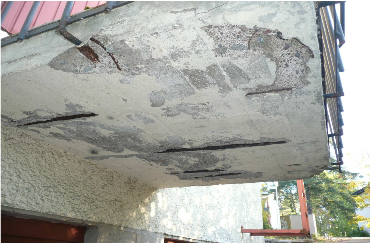
RAK- kuva 9. Yleiskuva eteläsivun parvekkeesta.
