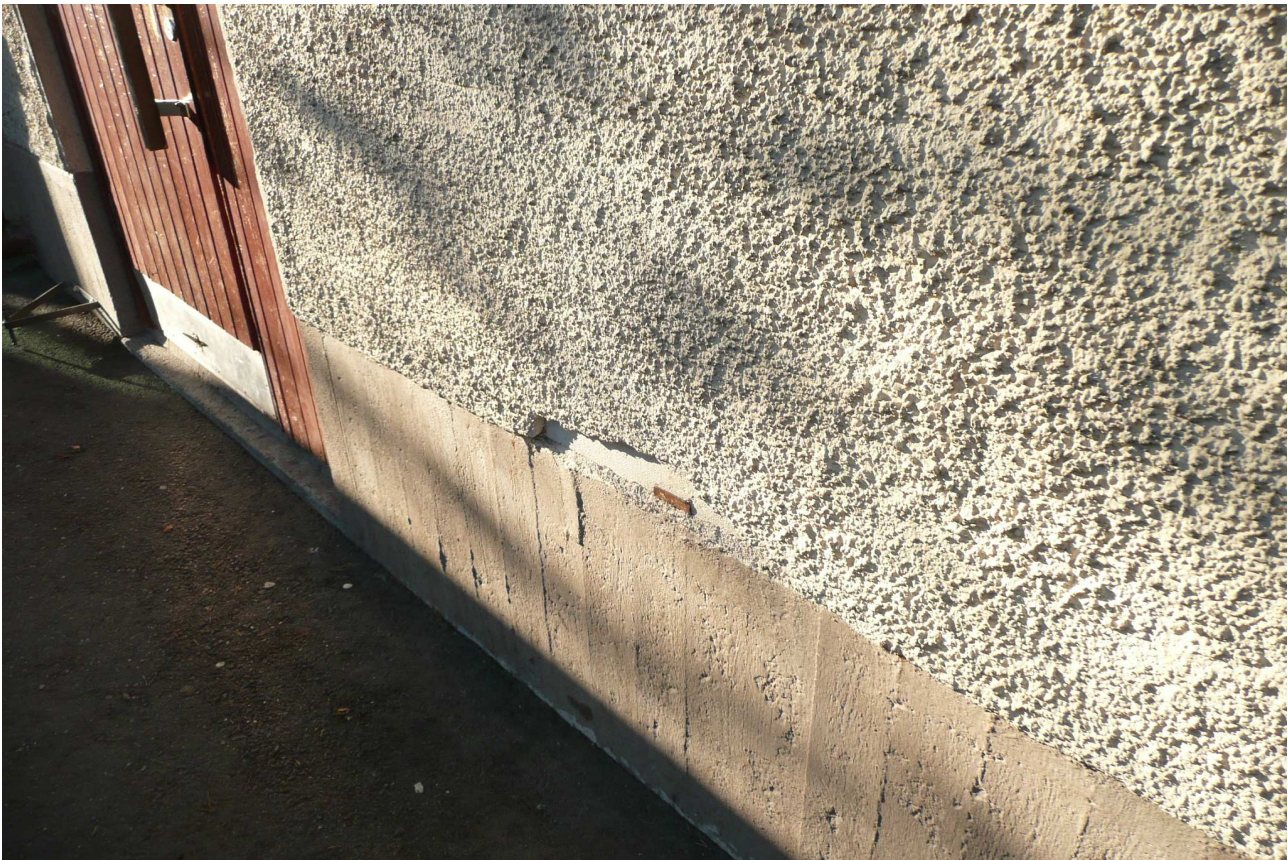
RAK- kuva 7. Yleiskuva rakennuksen julkisivusta.
