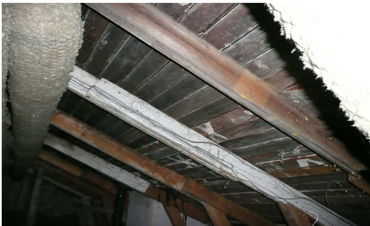
RAK- kuva 12. Yleiskuva ullakkotiloista.
