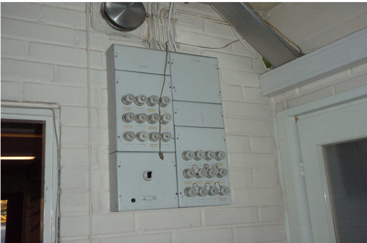
S- kuva 6. 2. kerroksen uusittu keskus.
