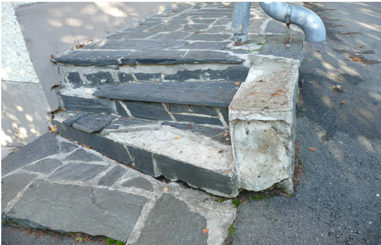
RAK- kuva 3. Yleiskuva eteläkulman betoniportaista.
