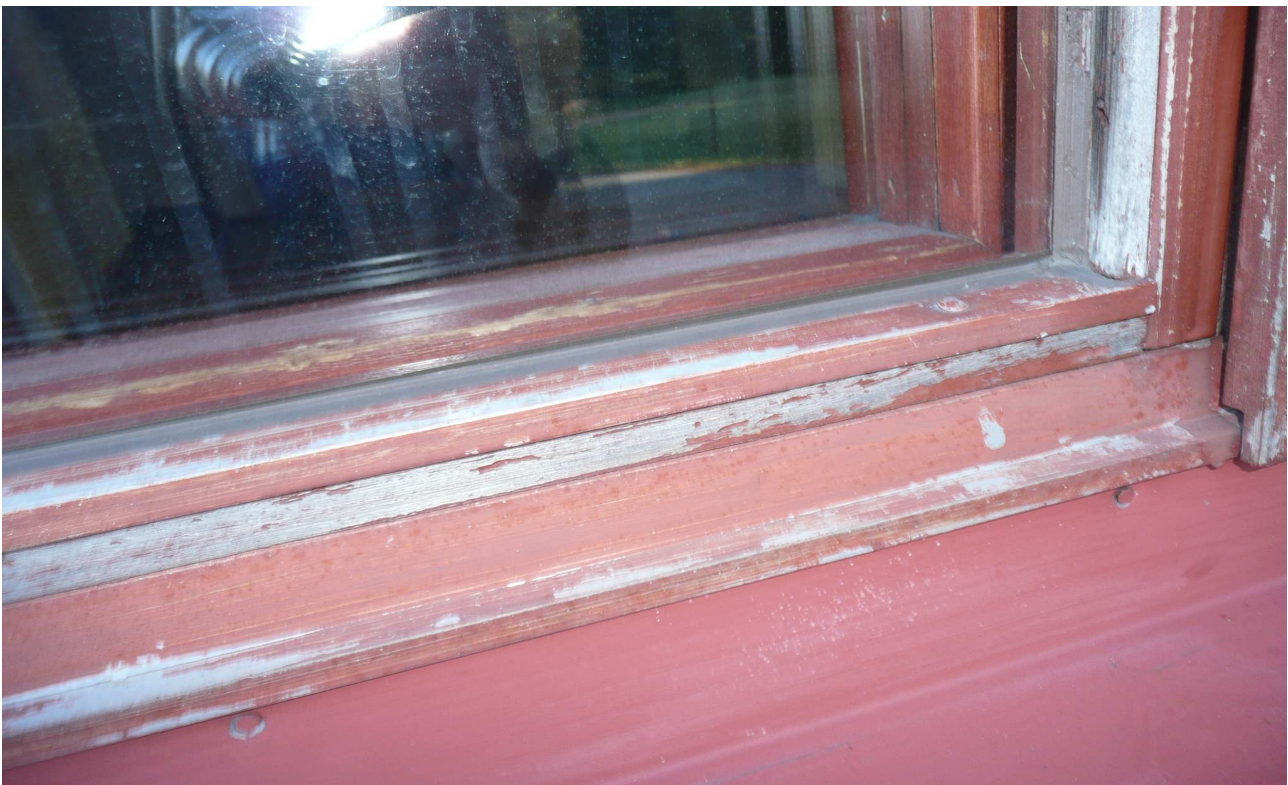
RAK- kuva 8. Yleiskuva rakennuksen ikkunoista.
