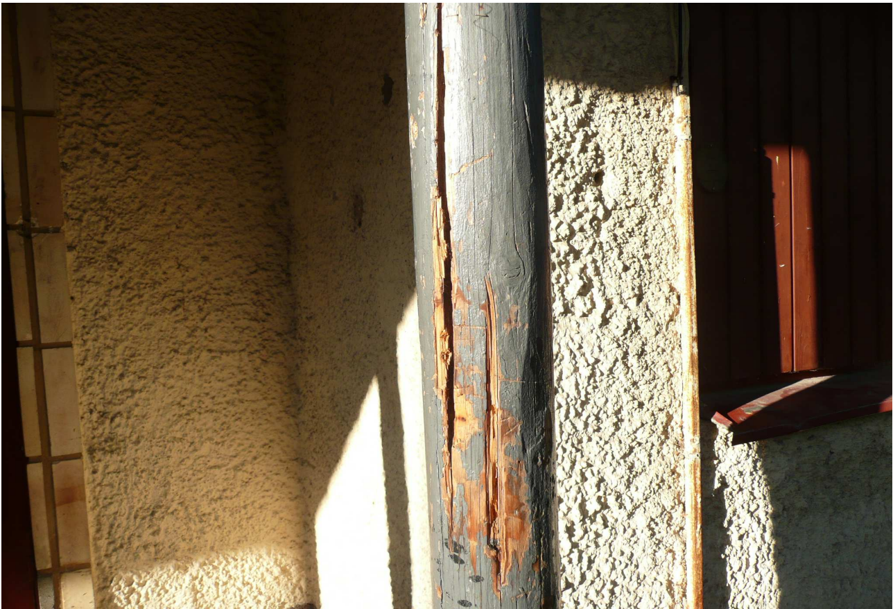
RAK- kuva 5. Yleiskuva räystäärakenteen puisesta tukitolpasta.
