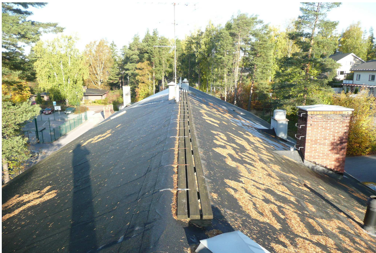
RAK- kuva 11. Yleiskuva vesikatolta.
