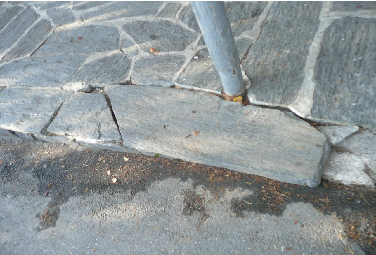
RAK- kuva 2. Yleiskuva pääsisäänkäynnin tasosta.
