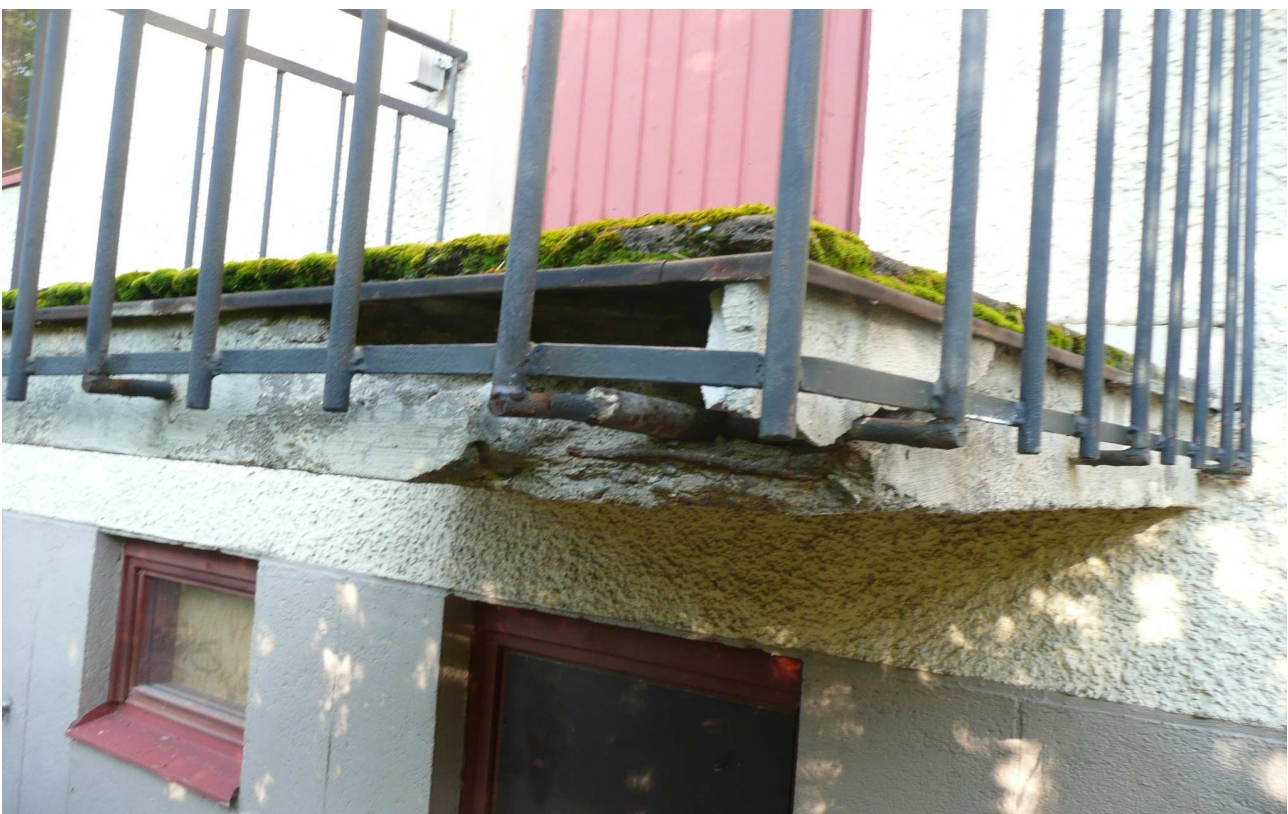
RAK- kuva 10. Yleiskuva eteläsivun parvekkeesta.
