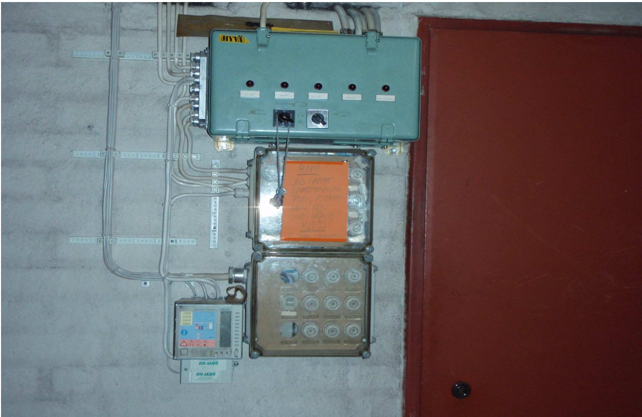
S- kuva 5. 2. kerroksen IV- koneikkoja palveleva keskus.
