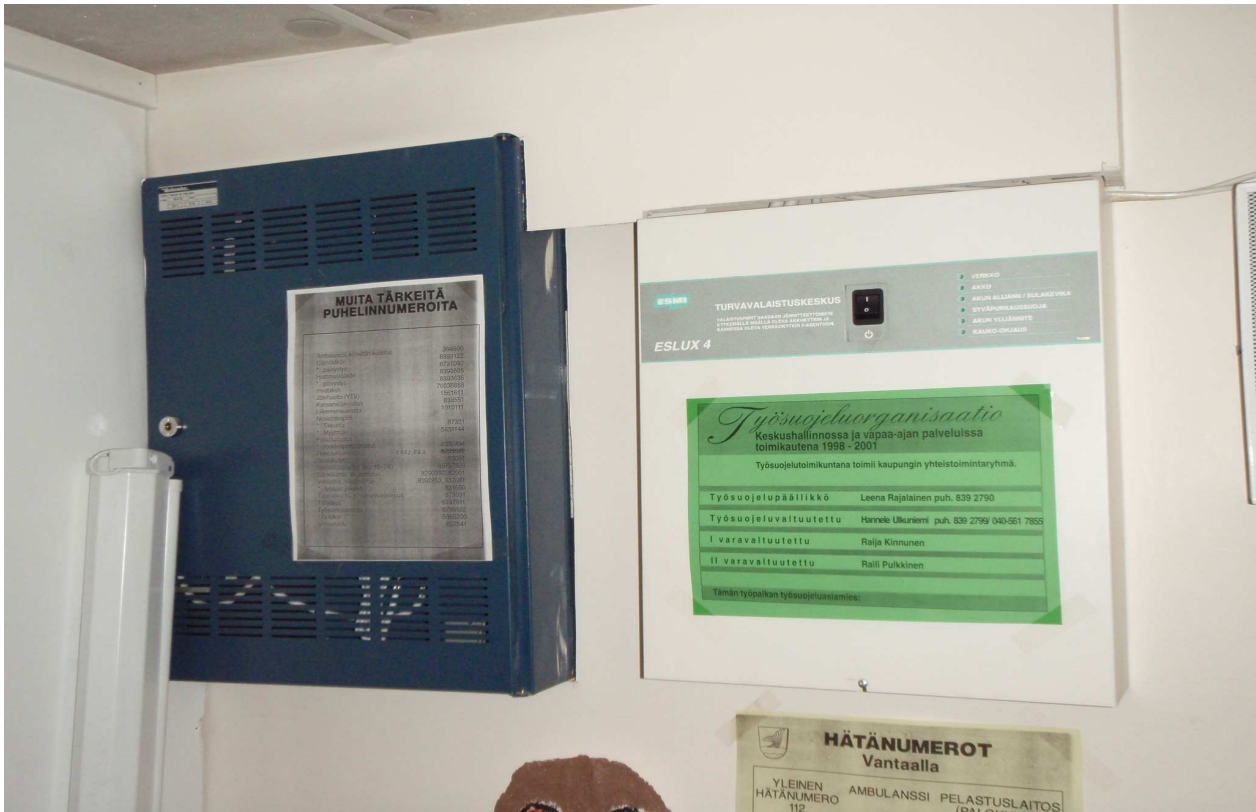
S- kuva 11. Ovimerkki / turvavalistusjärjestelmän keskus ja antennivahvistin.
