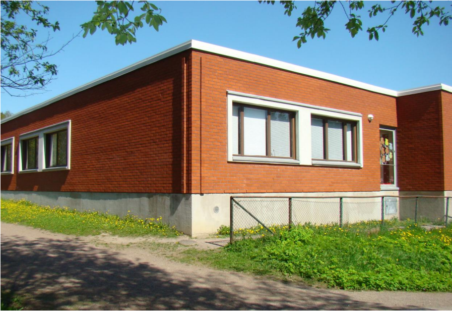
Kuva 12. Luokan L005 julkisivut. Kuvassa oikealla näkyy ryömintätilaan menevä luukku. Luukku on käytävän kohdalla.
