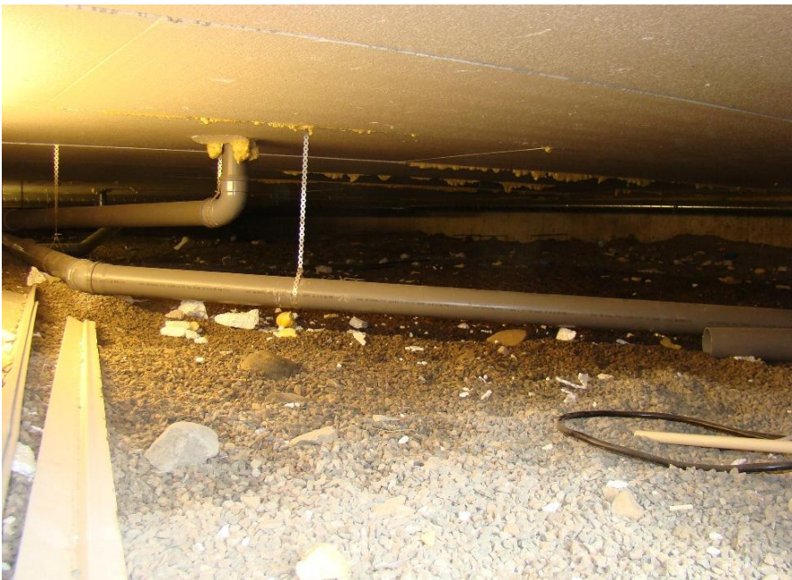
Kuva 11. Ryömintätallassa ei havaittu märkiä alueita eikä poikkeavaa hajua.
