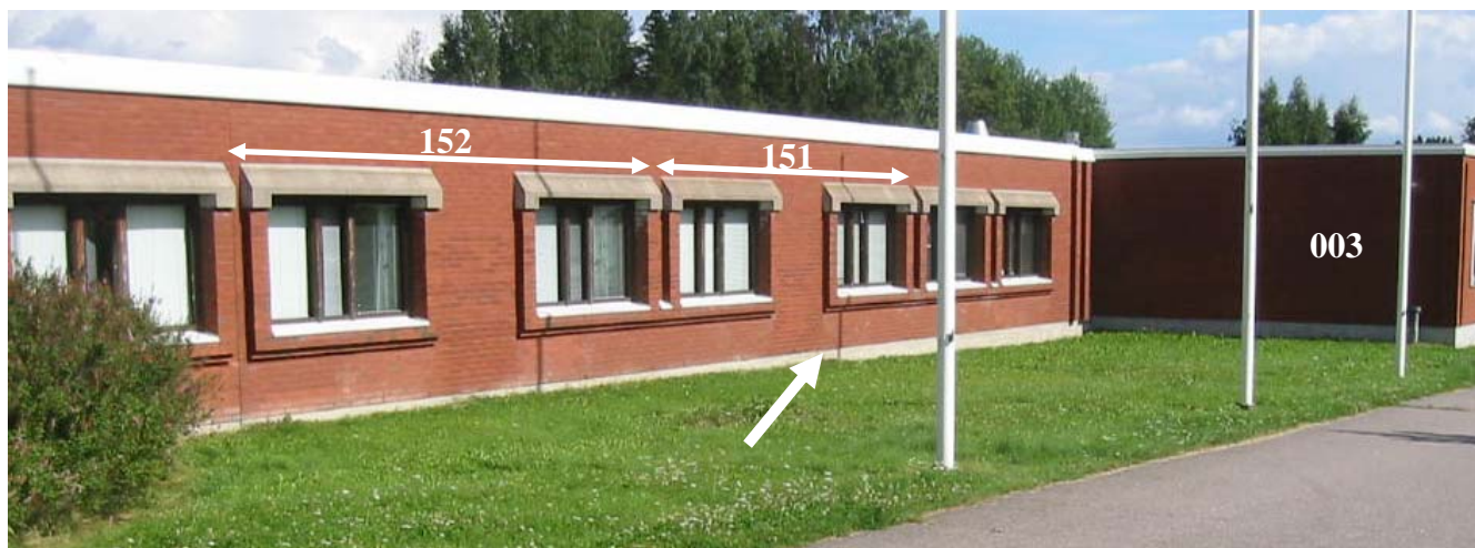
Kuva 16. Luokkien 151 ja 152 seinusta. Nurmikko on kiinni sokkelissa ja maanpinta on likimäärin lattiapinnan korkeudella. Nuolen kohdalla on paljon muurahaisia.
