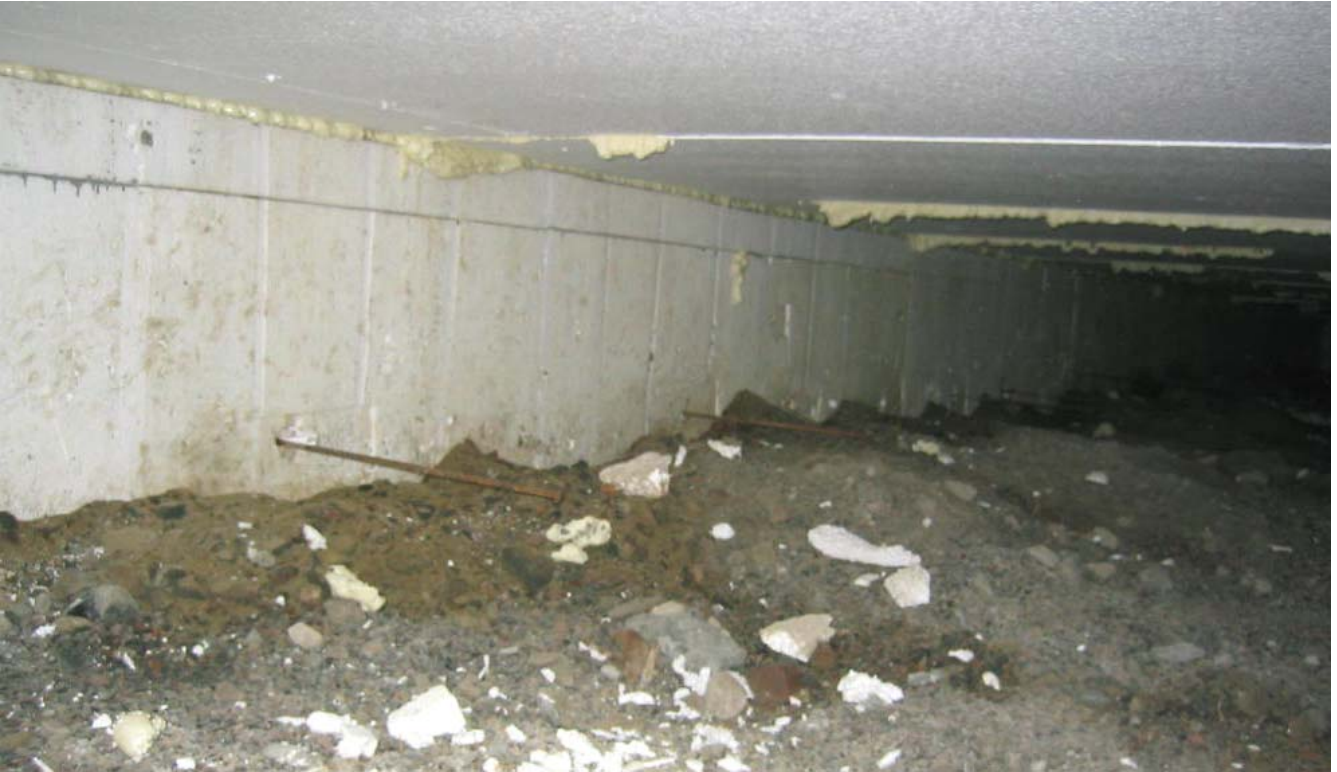
Kuva 13. Yleiskuva uuden puolen ryömintätilasta. Sepelin pinta oli kosteinta ulkoseinustoilla. Lämmöneristeiden väliset saumat on pääosin uretaanilla tiivistettyjä. Ryömintätilassa ei ollut yhtään orgaanista rakennusjätettä muutamaa laudankappaletta lukuun ottamatta. Laudankappaleet olivat aistinvaraisesti arvioituna vaurioitumattomia.
