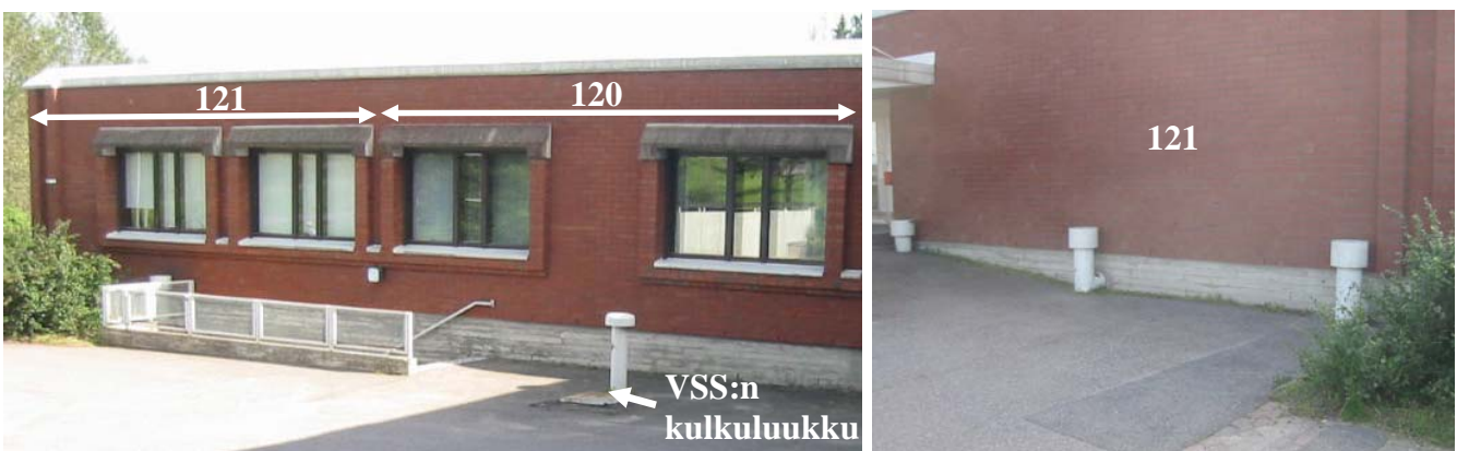
Kuva 18. Vasemmalla kellariin johtavat portaat luokkien 120 ja 121 edessä. Oikealla kellaritilojen tuuletusputket.
