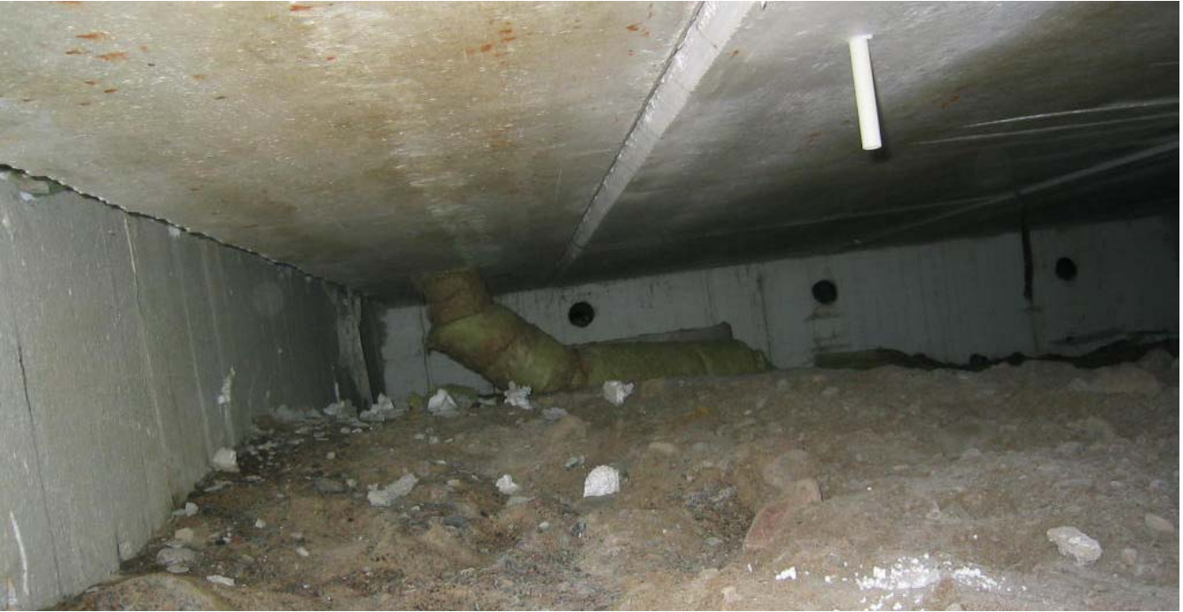
Kuva 17. Vanhan osan ryömintätilaa. Oikealla etualalla katossa näkyy alapohjan yli vallitsevan paineeron mittausputki ( \varnothing 16 mm).
