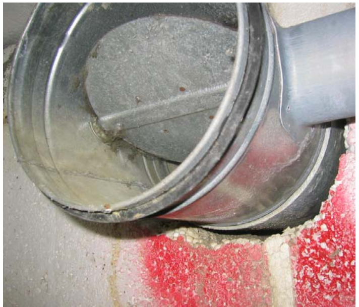
Kuva 14. Vasemmalla näkyy luokan 003 vanhan osan puoleisella seinustalla oleva tiivistämätön sokkelin sisäpuolisen lämmöneristeiden ja ontelolaatan alapuolisen lämmöneristeiden sauma. Oikeanpuoleisessa kuvassa näkyy luokan 003 ulkonurkassa sokkelin läpi tuleva tuubiputken ryömintätilan puolella oleva säätöpellillinen kanavan osa.
