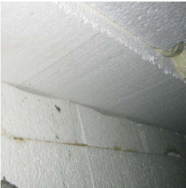
Kuva 14. Vasemmalla näkyy luokan 003 vanhan osan puoleisella seinustalla oleva tiivistämätön sokkelin sisäpuolisen lämmöneristeiden ja ontelolaatan alapuolisen lämmöneristeiden sauma. Oikeanpuoleisessa kuvassa näkyy luokan 003 ulkonurkassa sokkelin läpi tuleva tuubiputken ryömintätilan puolella oleva säätöpellillinen kanavan osa.
