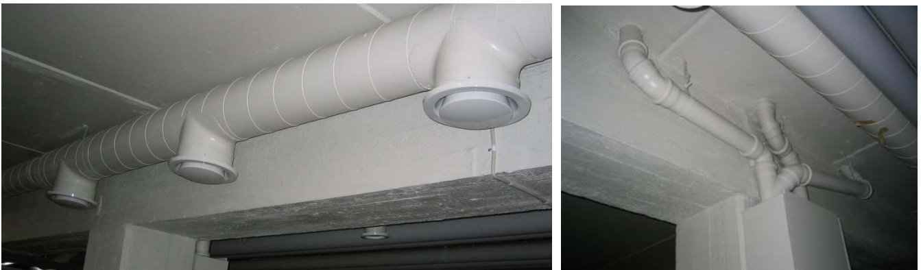
Kuva 20. Vasemmalla kellarin ilmanvaihtojärjestelmää ja oikealla putkiläpivientejä.
