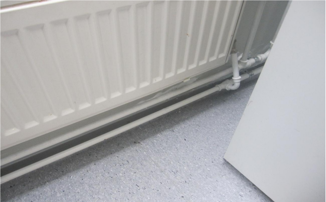
Kuva 1 ATK-luokan valokuilun kosteusvaurio
