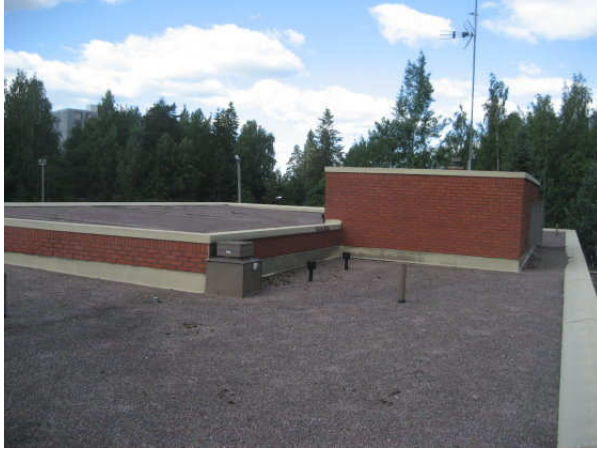
Kuva 1 Yleiskuva vesikatolta eteläpäädyn vesikatolta.
