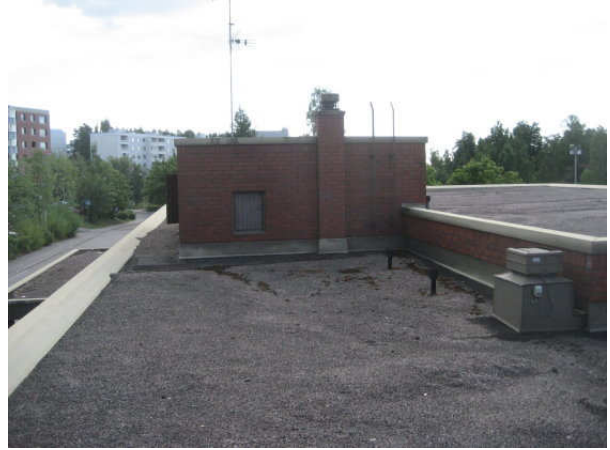
Kuva 2 Yleiskuva pohjoispäädyn vesikatolta.
