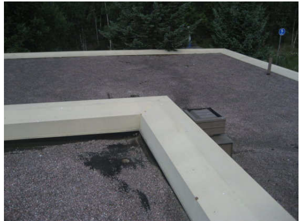
Kuva 4 Voimistelusalin koilliskulman katto-vesikaivo, siivilä puuttuu
