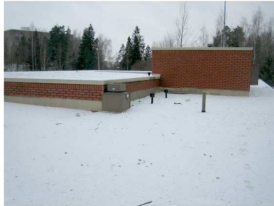
Kuva 8 Rakennuksen vesikattoa. Lumi-/ jääpeite vaikeutti havaintojen tekoa.
