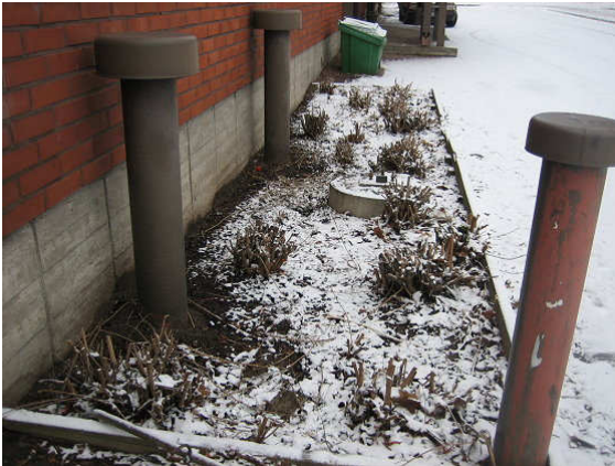
Kuva 1 Itäsisivustalla on rakennuksen vierustalla multamaata.
