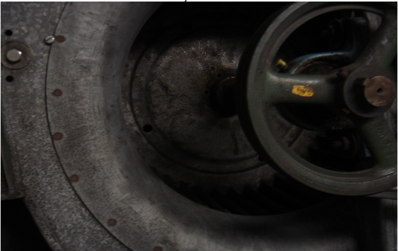
LVI-kuva 11. Puhallin on nokinen.
