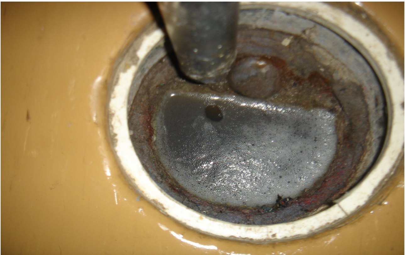
LVI-kuva 9. Lattiakaivot ovat valurautaa.
