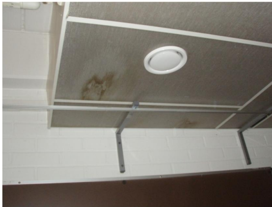
Kuva 7. Luokan 063 vastaisen väliseinän vieressä katon akustiikkalevyissä on vanhoja vuotojälkiä. Välipohjalaatta on kuiva.
