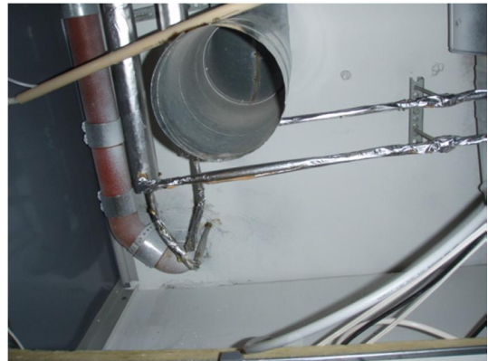
Kuva 7. Luokan 063 vastaisen väliseinän vieressä katon akustiikkalevyissä on vanhoja vuotojälkiä. Välipohjalaatta on kuiva.
