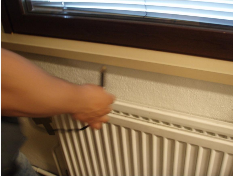
Kuva 5. Luokassa 066 oli yksi vuokohta ikkunapenkin alapuolella.
