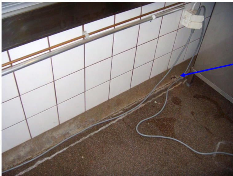
Kuva 10. Keittiön ruokalan puoleisen seinän akrylibetonin nosto vaikutti olevan irti alustastaan. Nostoon oli tehty myös lovia.
