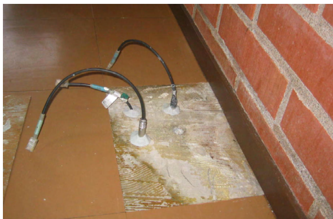
Kuva 7. Ruokalan linjaston edessä ollut porareikämittapiste numero 2. Mittapääät ovat asennettuina mittaussreikiin.
