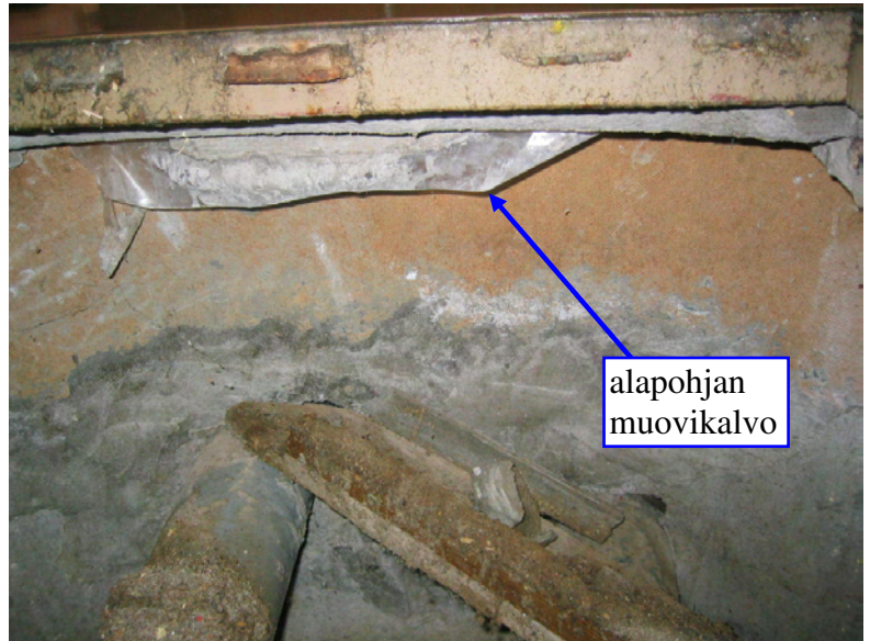
Kuva 14. Käytävällä 1031 olleen lattian tarkastusluukun alla oli jonkin verran orgaanista ainesta. Aukon reunalla oli näkyvissä alapohjarakenteen muovikalvo.
