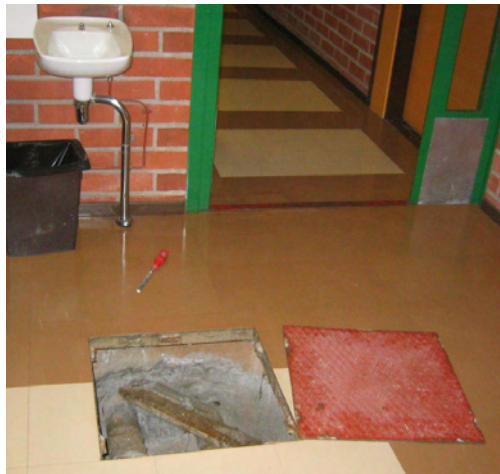
Kuva 14. Käytävällä 1031 olleen lattian tarkastusluukun alla oli jonkin verran orgaanista ainesta. Aukon reunalla oli näkyvissä alapohjarakenteen muovikalvo.
