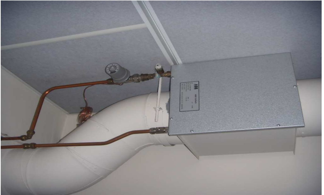
KUVA 7. Yleiskuva jälkilämmityspatterista.
