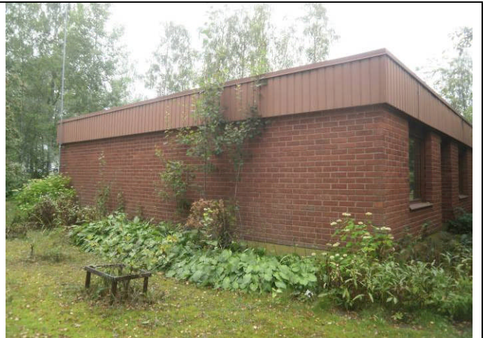
8. Julkisivua sivupiikan puolella.
